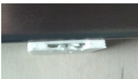
Obr. 23 Díra vyplněná podporami
