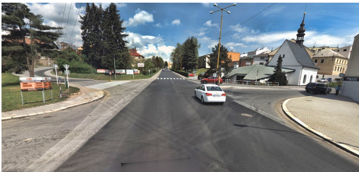
Obrázek 6 - Rozlehlost křižovatky ulic Nová cesta, Čs. armády, Radotínská [2]
