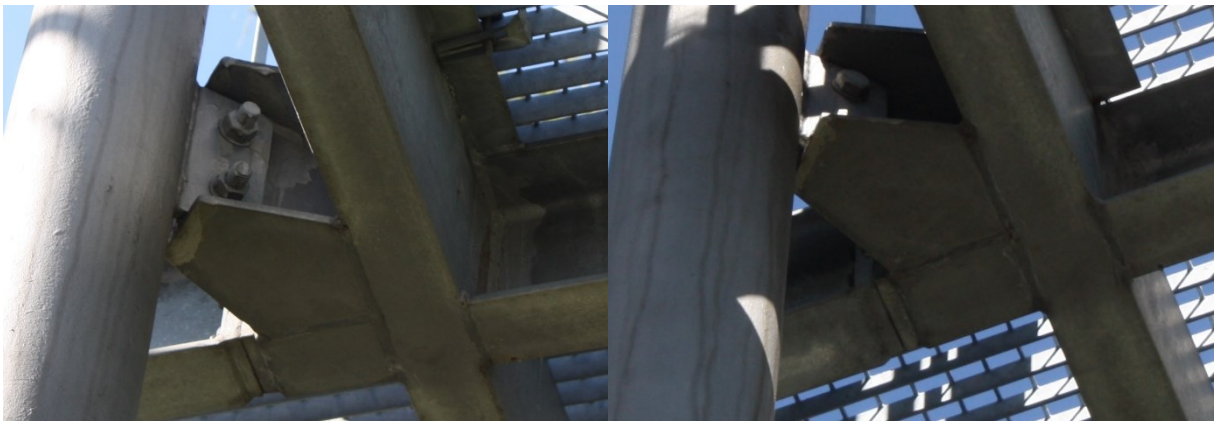
Obr. 2.3 - 6 – Detail kotvení schodiště 1
