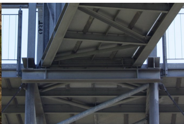
Obr. 2.3 - 4 – Připojení příčnicí držící lávku 2
