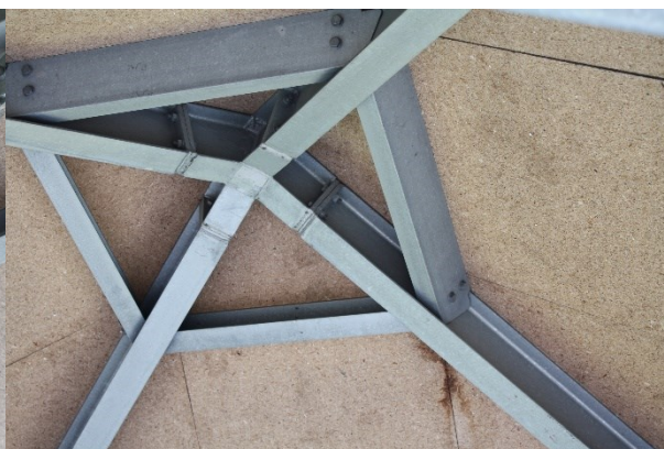
Obr. 2.3 - 2 – Pohled na vrchol střešní konstrukce
