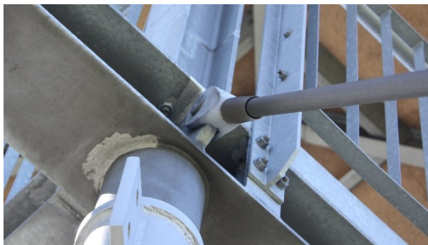
Obr. 2.3 - 13 – Kotvení tyčí 1
