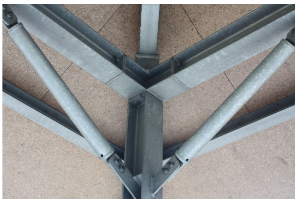
Obr. 2.3 - 1 – Pohled připojení sloupu na příče
