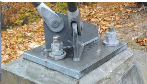
Obr. 2.3 - 14 – Kotvení tyčí 2
