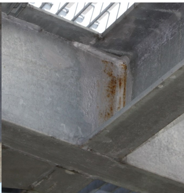
Obr. 2.3 - 11 – Detail propojení vnitřních schodnic
