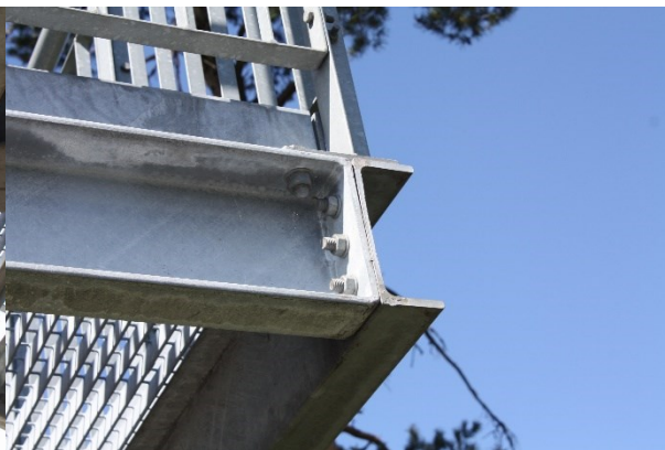
Obr. 2.3 - 9 – Detail propojení vnějších schodnic
