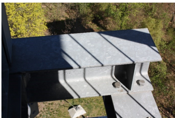
Obr. 2.3 - 3 – Připojení příčnicí držící lávku 1
