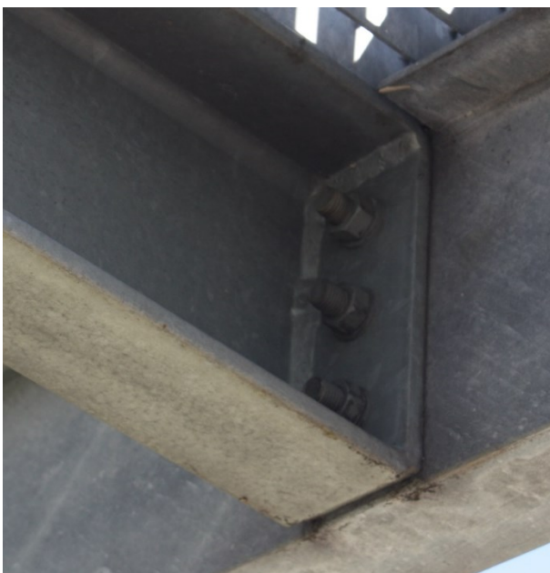
Obr. 2.3 - 10 – Detail napojení vnitřní schodnice na vnější
