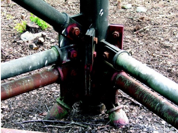
Obr. 1.2 - 1 – Stav před rekonstrukcí [8]
