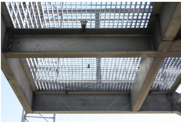
Obr. 2.3 - 8 – Propojení schodnic schodiště
