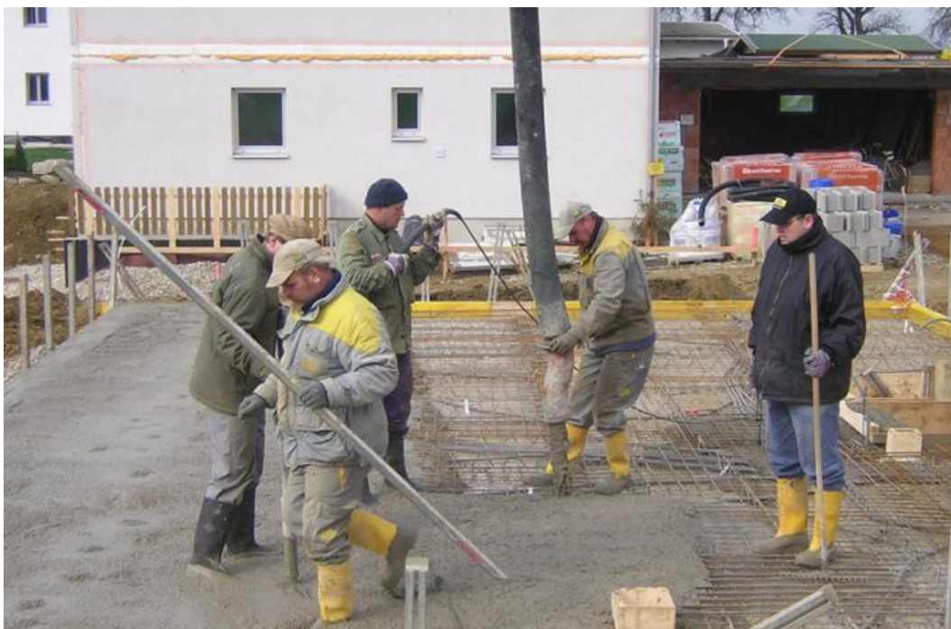
Obr. č. 6 Betonáž podkladní desky
