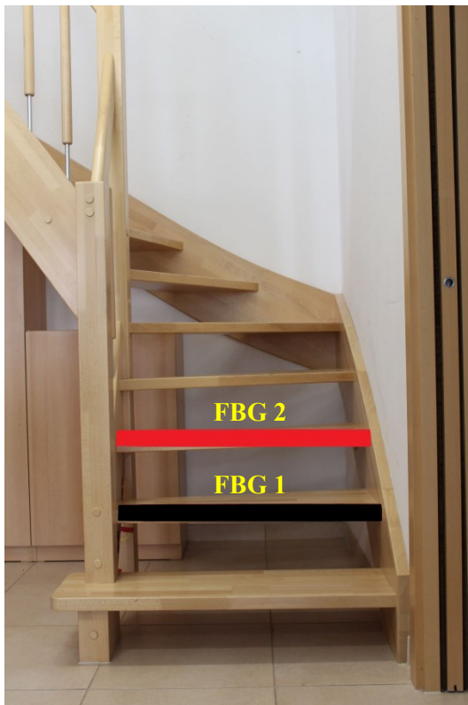
Obrázok 4.6: Schodisko kde boli umiestnené sklolaminátové FBG senzory
