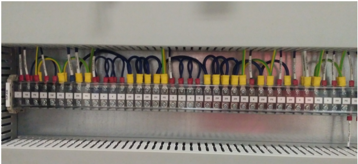
Obr. 9 Svorkovnice rozvaděče
