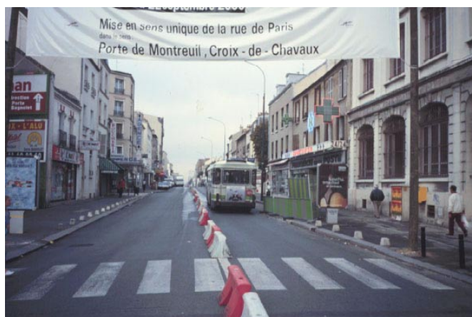
Montreuil : mise en sens unique de l'avenue de Paris et couloir bus
