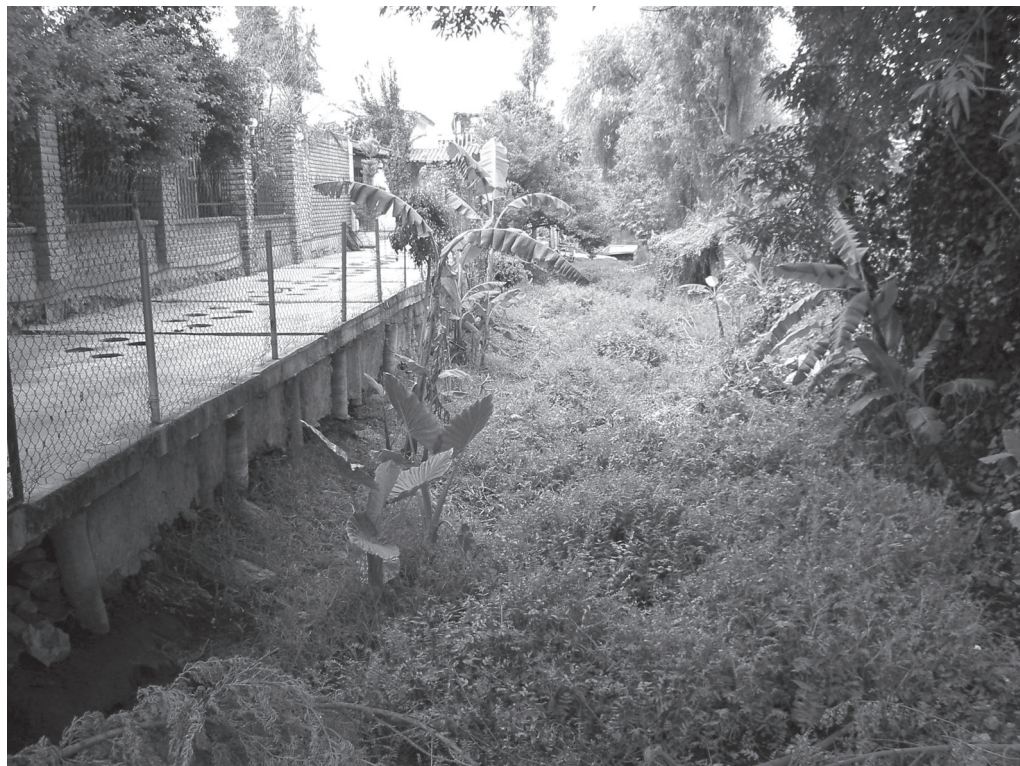
Figure 4. Filled-in canal, Ampliación San Marcos.
