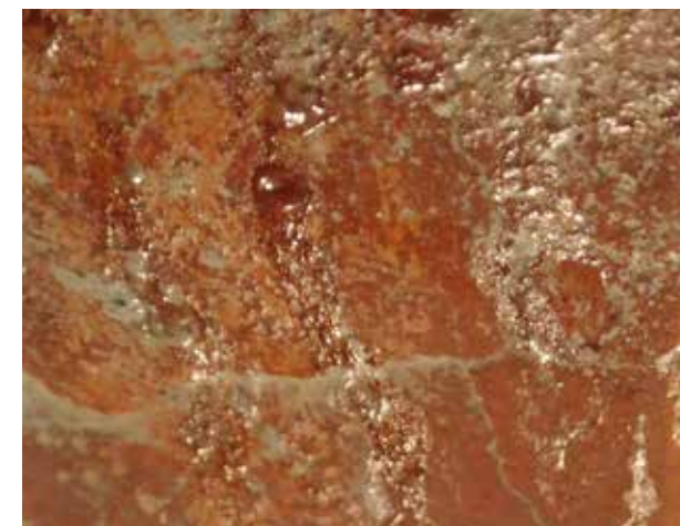
224. Particolare durante la pulitura: presenza di gocce di resina epossidica sulla superficie policroma, probabilmente residui di un intervento sulla travatura sovrastante.
