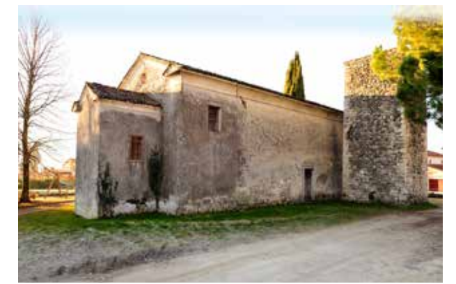
93. Esterno, lato nord. Si nota il punto di giunzione fra l'antica struttura architettonica, corrispondente all'attuale aula, e la parte aggiuntiva del presbiterio.
