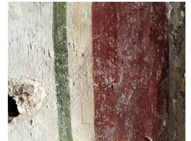
119. Particolare dopo la rimozione dello strato di scialbo
