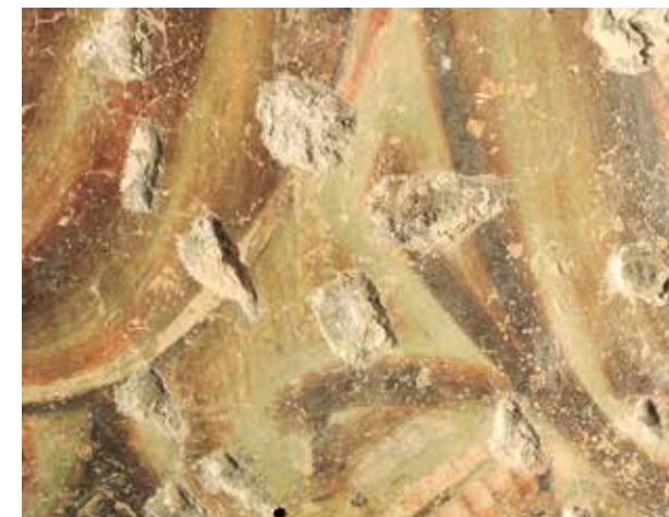
226. Particolare durante il restauro: risultato della rimozione delle vecchie stuccature.
