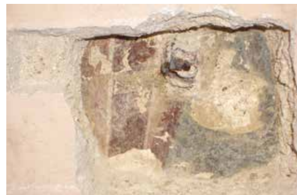
95. Particolare durante le indagini: ritrovamento di una superficie policroma durante l'esecuzione di una stratigrafia.
