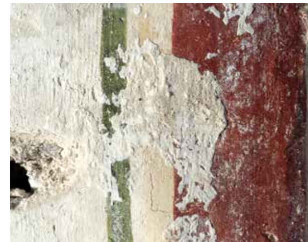
118. Fase di rimozione dello strato di scialbo, particolare durante le operazioni.
