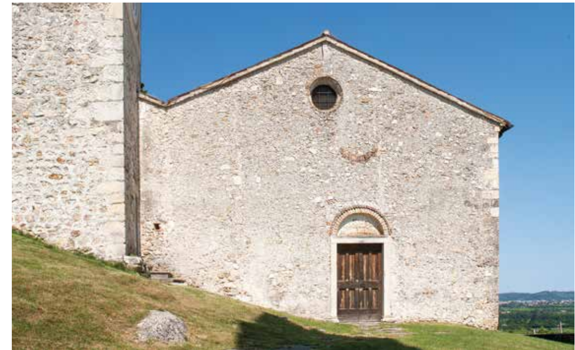
282. La facciata della chiesa di San Vigilio. Sono visibili le tracce degli ampliamenti successivi. L'oculo sommitale non risulta in asse con quello precedente e il portale d'accesso.
