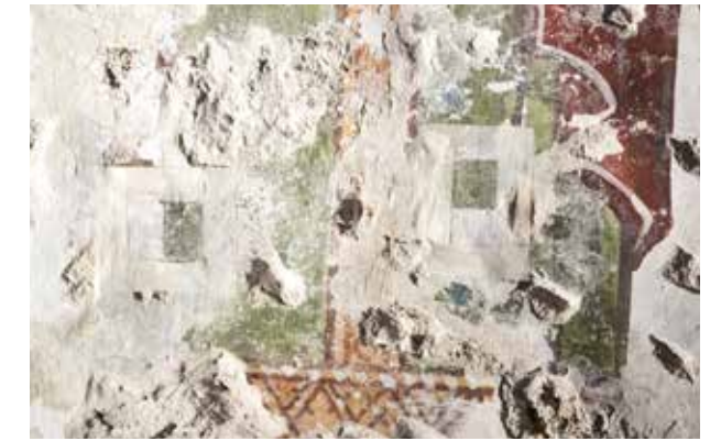
117. Particolare durante il restauro: campione di pulitura in un'area dove precedentemente è stato effettuato un preconsolidamento.
