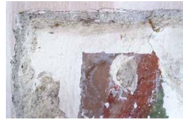
116. Particolare durante il restauro. Campione di descialbo in un'area dove è stato rimosso l'intonaco sovrapposto dello spessore di circa 5 cm. Fra lo strato d'intonaco e la superficie policroma si è in presenza di uno strato di scialbo bianco.
