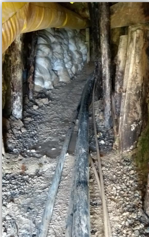
Fotografía 1. Ducto de ventilación Mina La Toma
