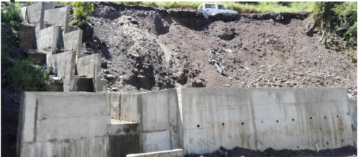
Figura 15. Muro de contención del K16+500 terminado
