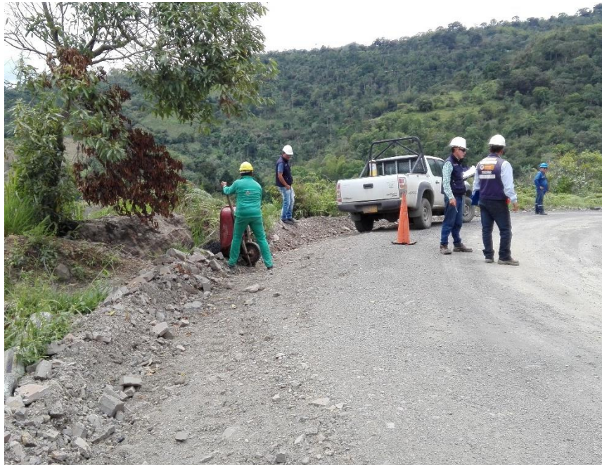
Figura 16. Estado de la capa de base granular antes de realizar riego de imprimación
