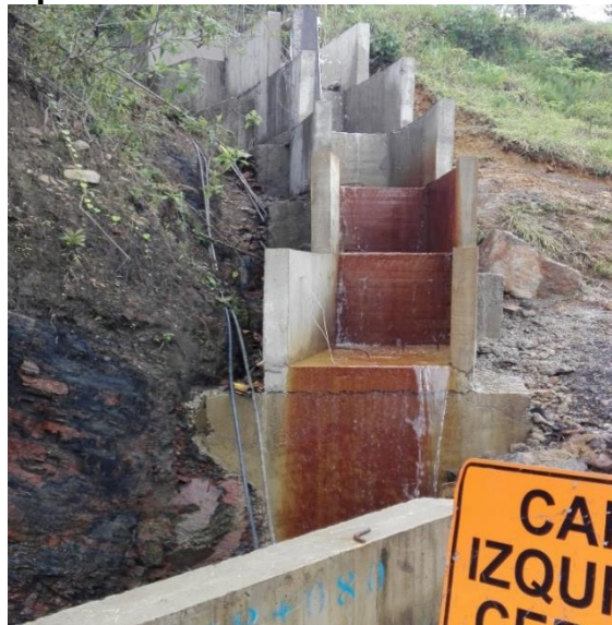
Figura 25. Canal de rápida escalonada del K8+080
