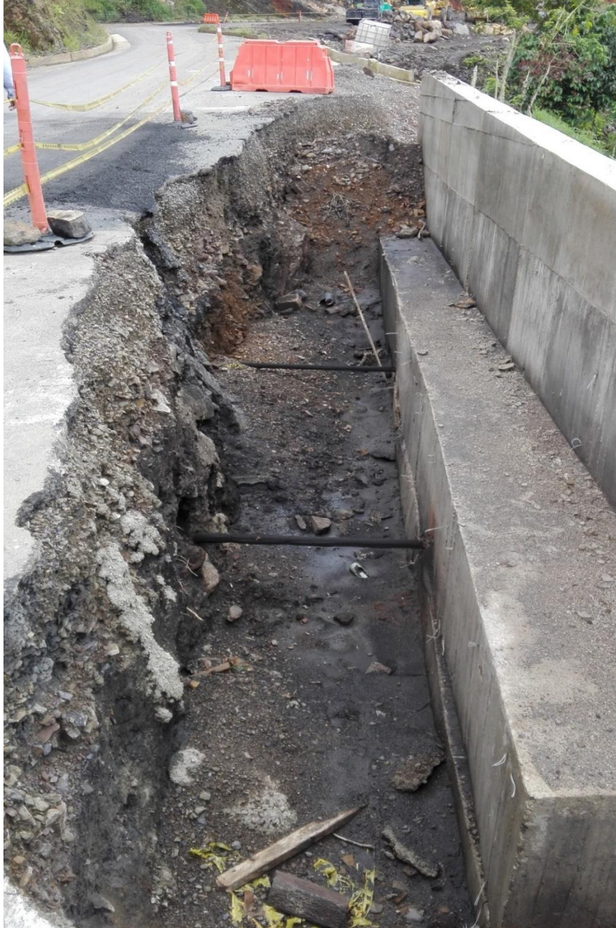
Figura 10. Viga de cimentación del K11+100, drenes
