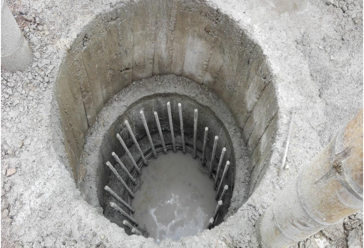
Figura 8. Curado del concreto del caisson N°2 del K11+100
