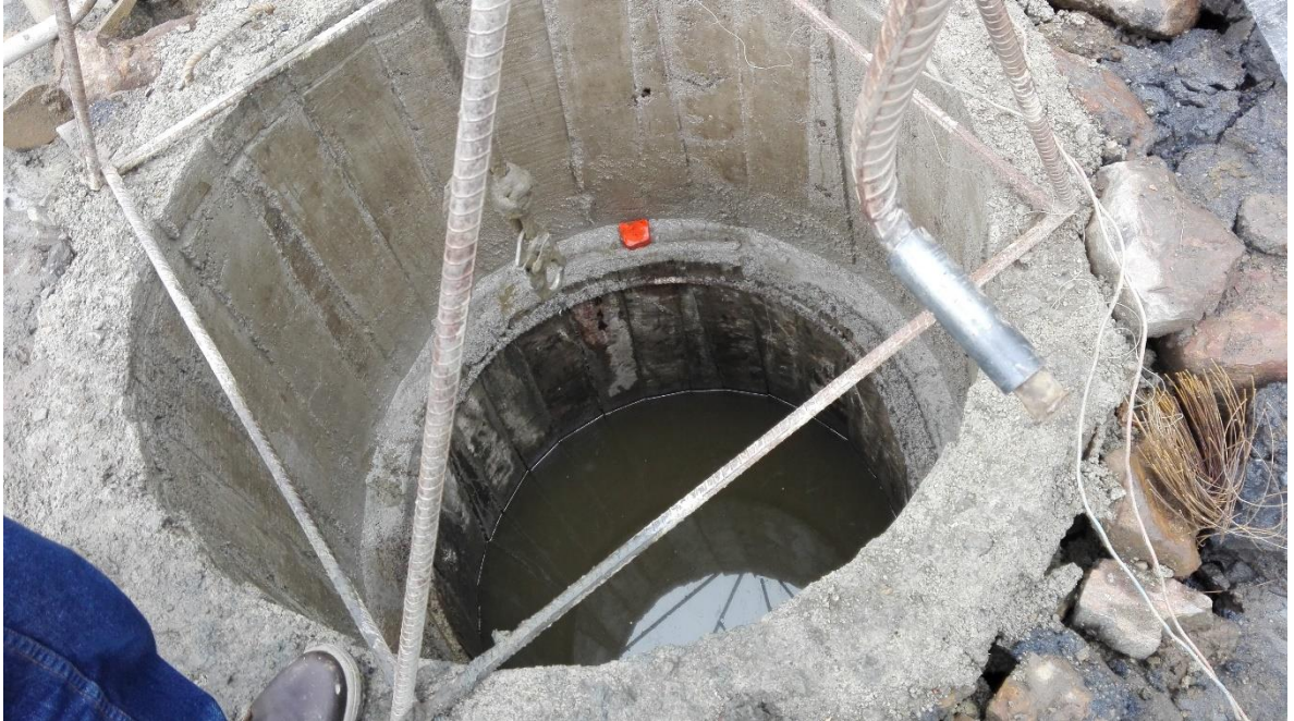
Figura 14. Curado del segundo anillo del caisson N°2 K16+500.
