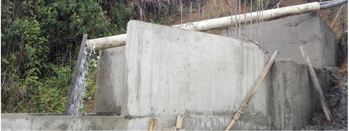
Figura 26. Tubo usado como disipador
