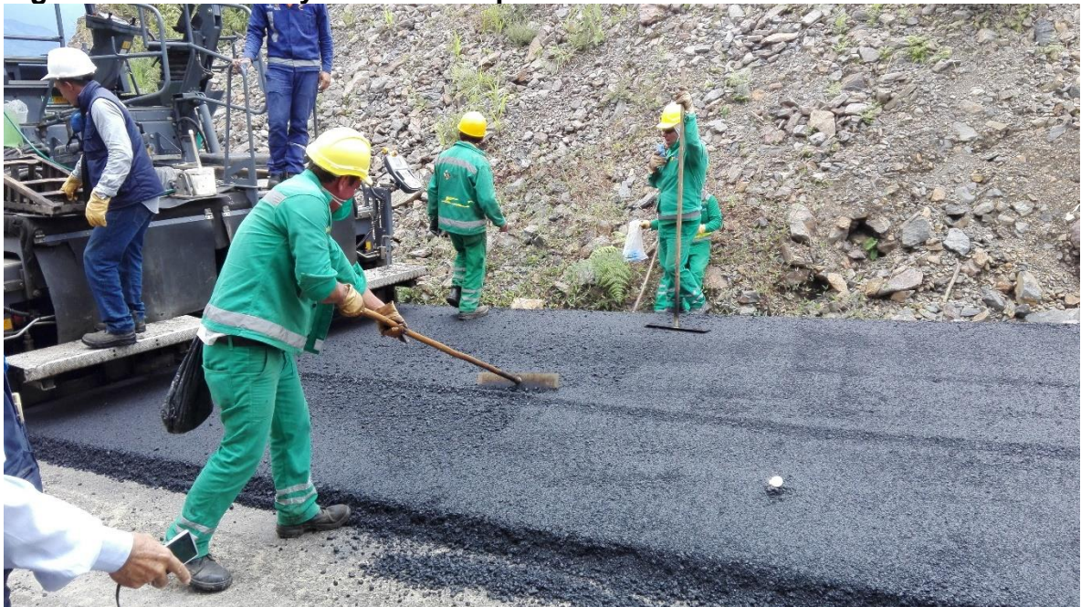
Figura 19. Extendido y toma de temperaturas de la mezcla asfáltica K14+920
