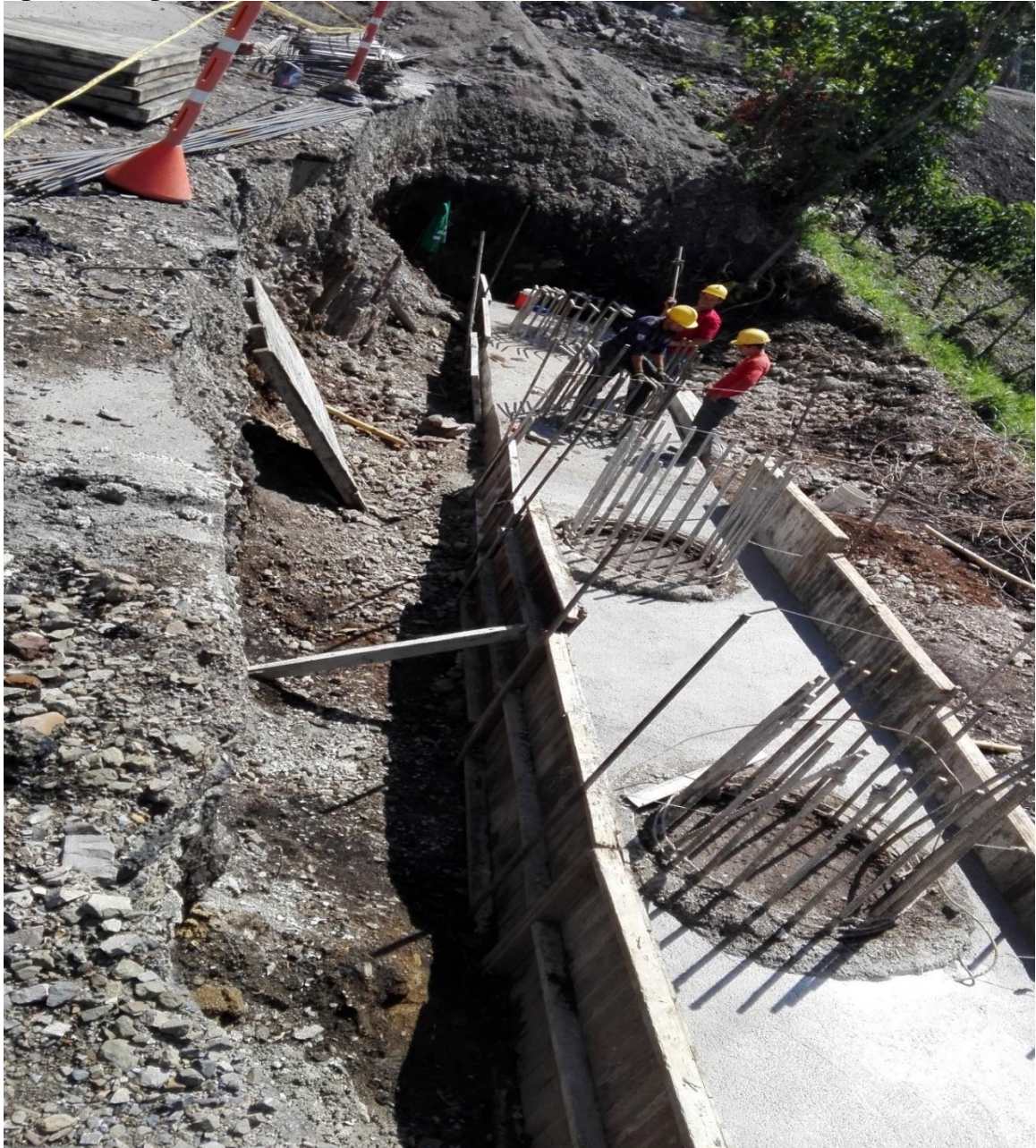
Figura 9. Viga de cimentación del K11+100
