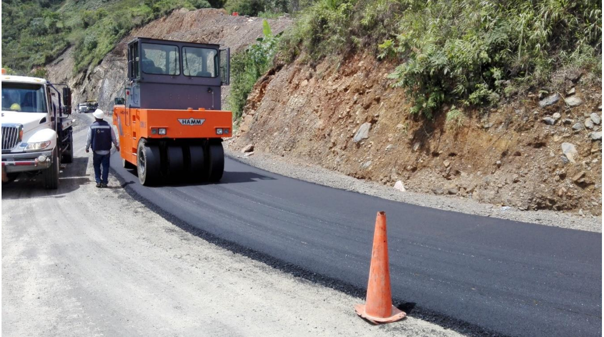
Figura 20. Compactación de la carpeta asfáltica K15+020
