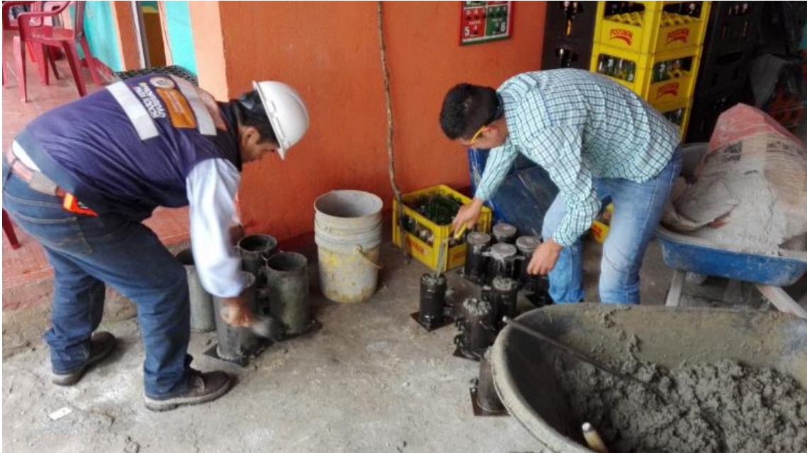
Figura 4. Preparación del molde para medir asentamiento del Caisson N°2 del K11+100
