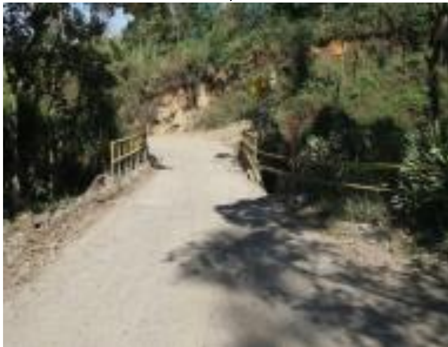
Figura 29. Pontón Quebrada Honda, K3+500
