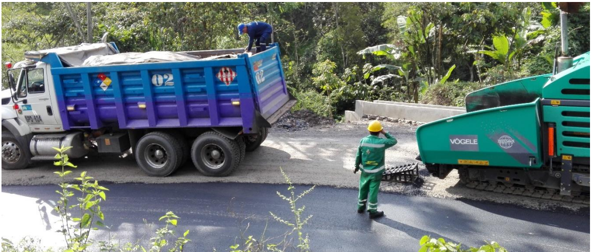
Figura 22. Uso de rampas metálicas para deposición de la mezcla asfáltica en la finisher K16+430
