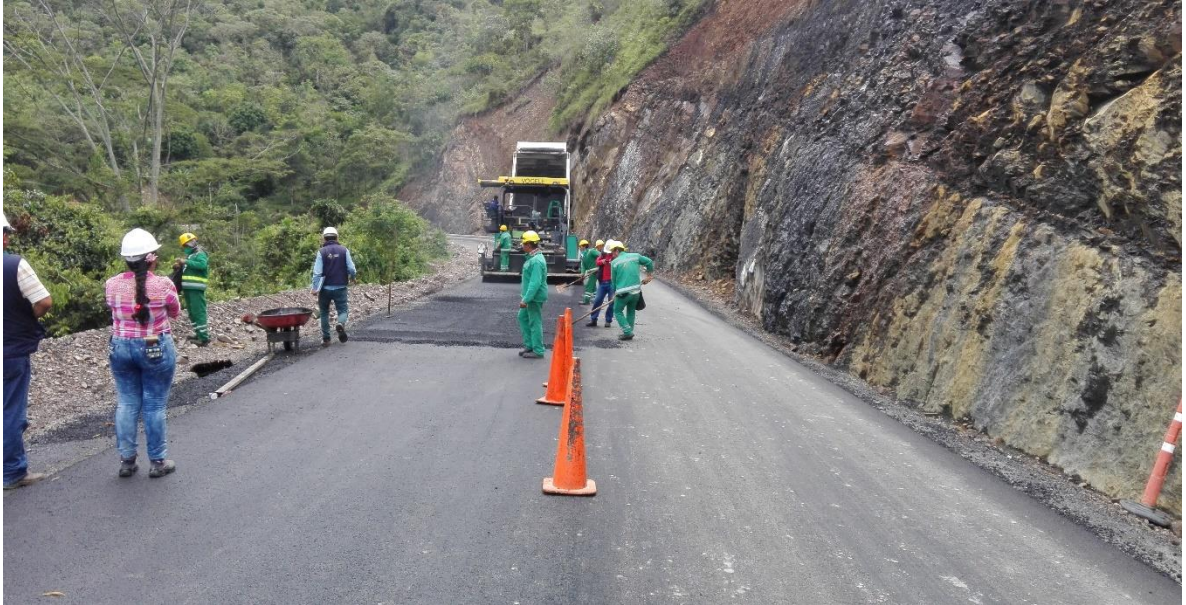
Figura 21. Extendido de la mezcla asfáltica K15+140
