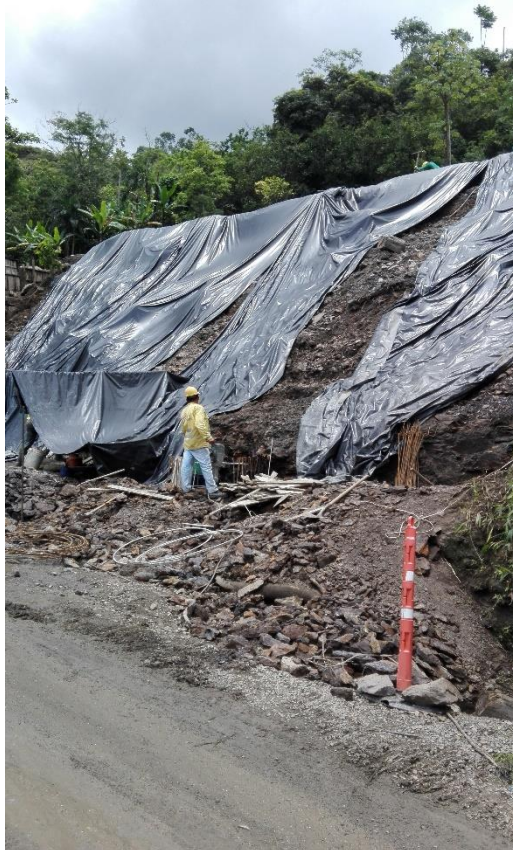
Figura 12. K16+500 antes de la construcción del muro de contención
