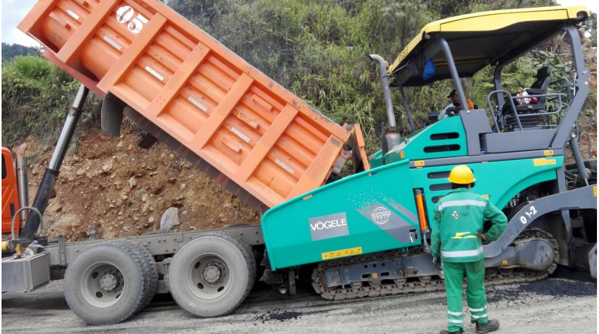
Figura 18. Depósito de la mezcla asfáltica en la finisher K14+910
