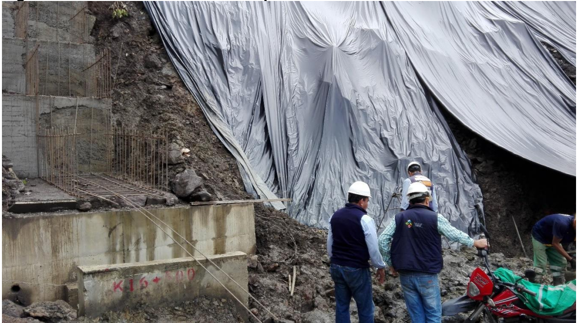
Figura 13. Excavación de caissons para el muro de contención del K16+500
