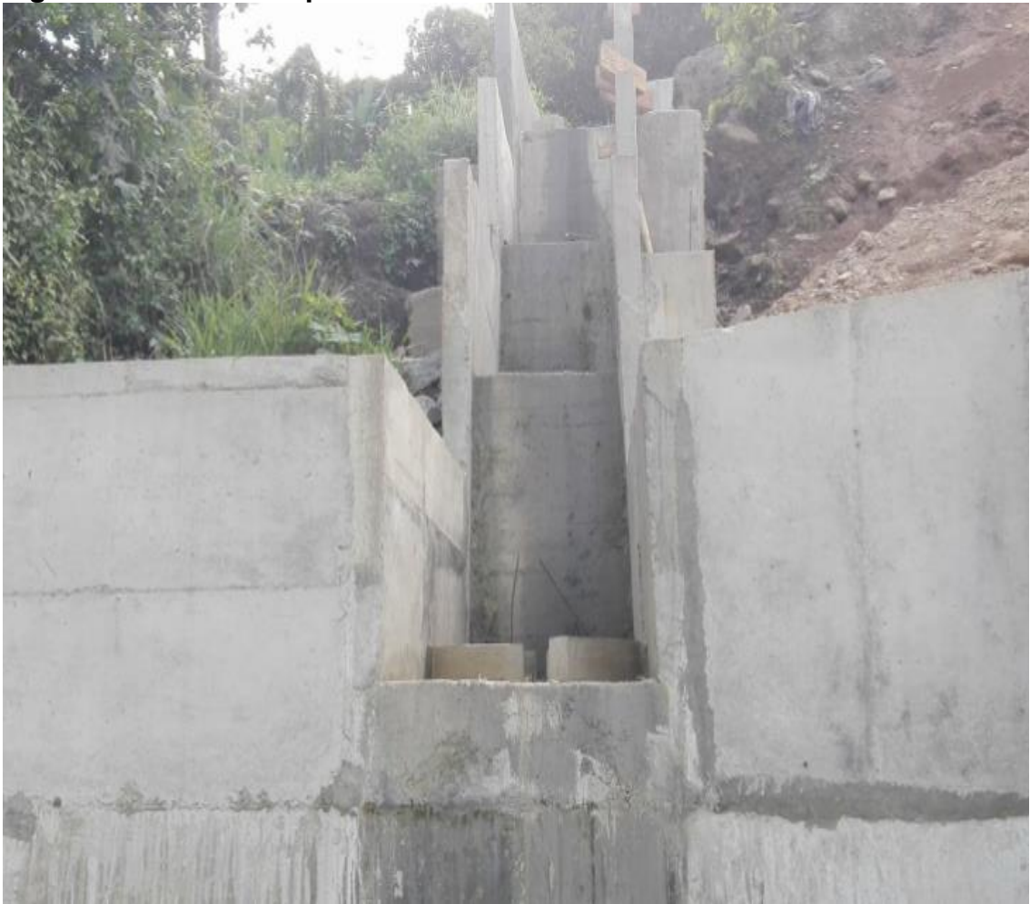
Figura 28. Canal de rápida escalonada del K16+500
