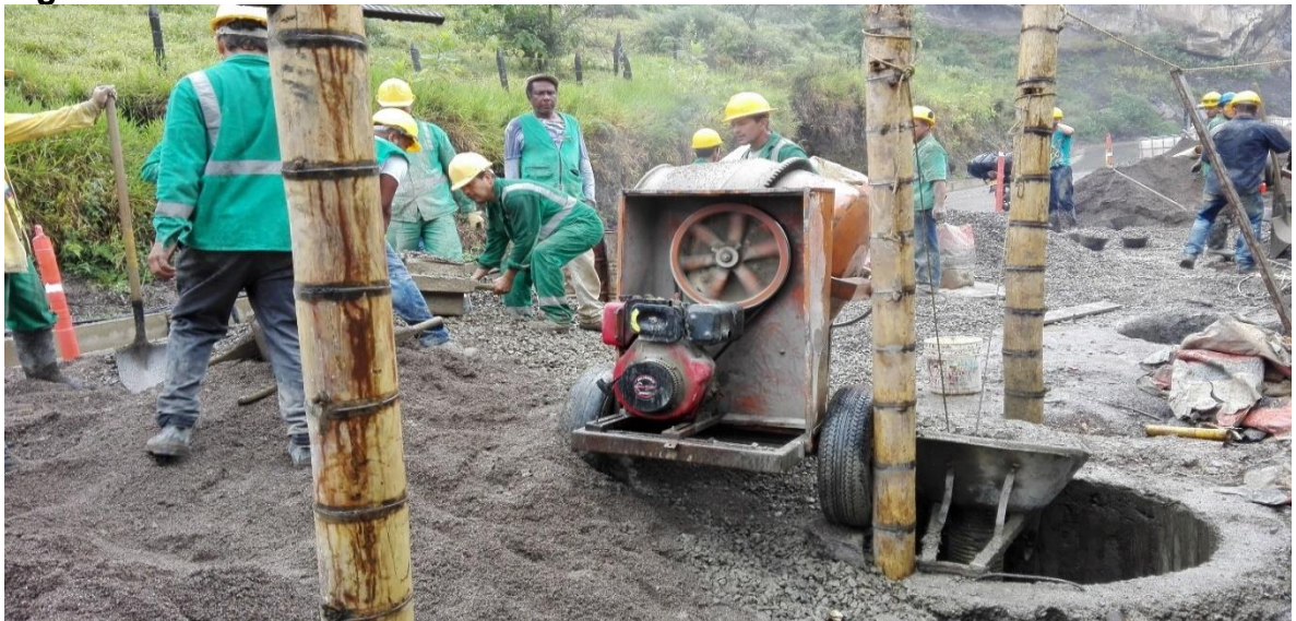
Figura 3. Vertido de concreto del anillo N°2 del caisson N°2 del K11+100
