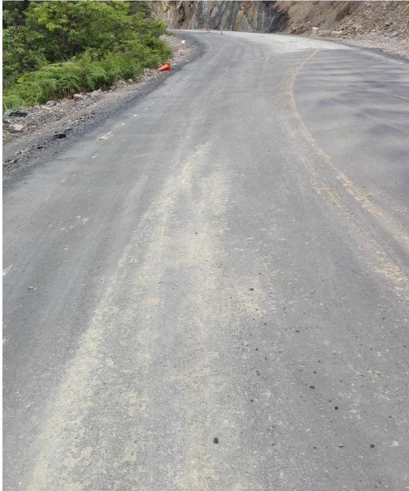
Figura 17. Riego de imprimación K15+140
