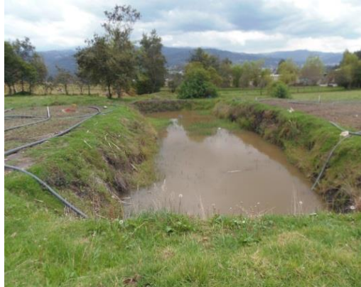
Foto 15 Reservorio para riego
