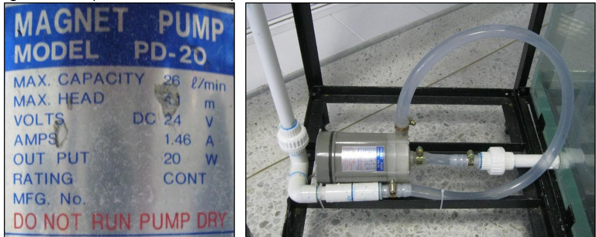
Figura 14. Especificaciones e implementación de la motobomba.
