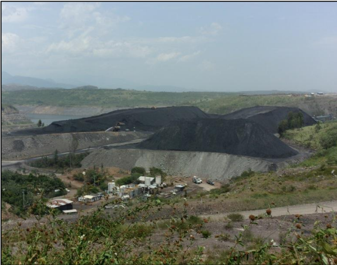
Figura 9. Patio de acopio
