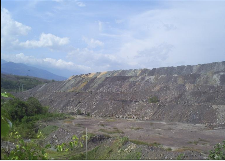
Figura 10. Disposición de material estéril en botadero.
