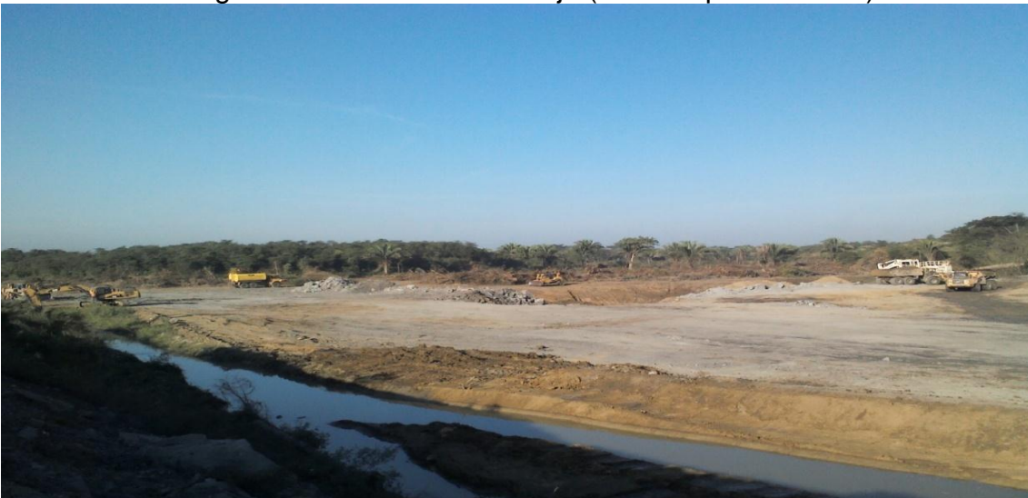
Figura 30. Labores de drenaje (canales perimetrales).
