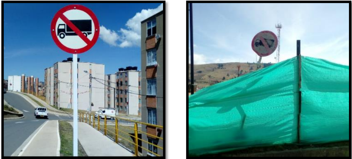
Figura 31. Comparación entre Señal Vertical en buen Estado y Mal Estado
