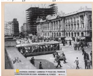
Figura 4. Construcción edificio de la Caja Agraria en Bogotá.
