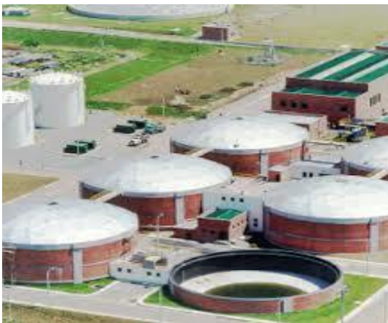
Imagen 6. Planta de tratamiento en cañaveralejo.
