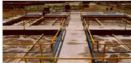
Figura 1. Sitio de disposición de llegada de aguas residuales.
