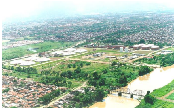
Imagen 4. Planta de tratamiento en cañaveralejo.
