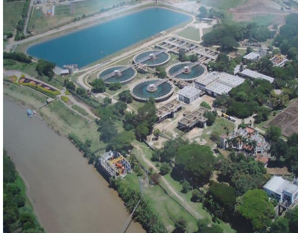
Imagen 5. Planta de tratamiento en Cañaveralejo.
