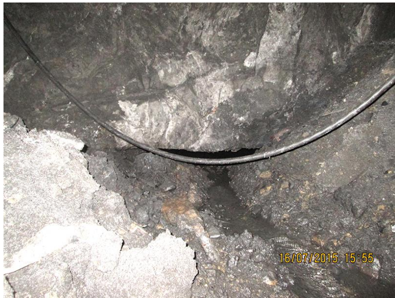
Foto 23: Flujo de agua desde la base de un pilar (Machón colgado).
