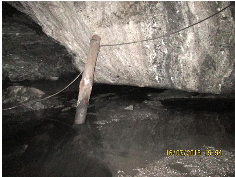
Foto 22: Pilar colgado por disolución de la base.
