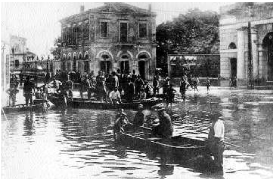
Porta Pradella durante l'alluvione del 1917.
