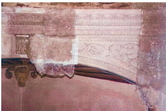
Fig. 15. Camerino delle Grottesche: dettaglio del cornicione in stucco in fase di pulitura (foto: Arké - Marchetti & Fontanini)
