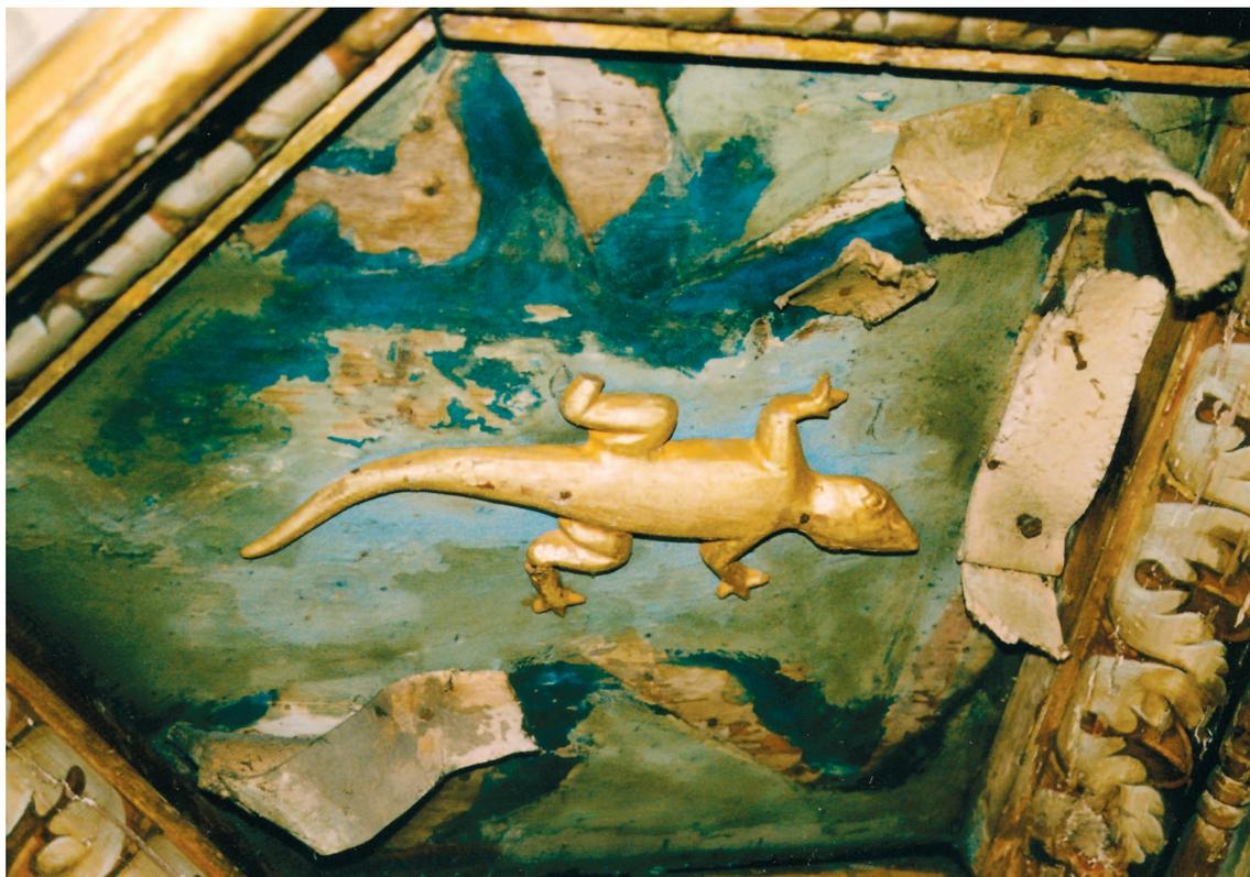
Fig. 7. Sala dei Cavalli: cassettoni con l'impresa della Salamandra prima del restauro: particolare del nastro e tracce del fondo azzurro originali (Archivio Museo Civico di Palazzo Te)
