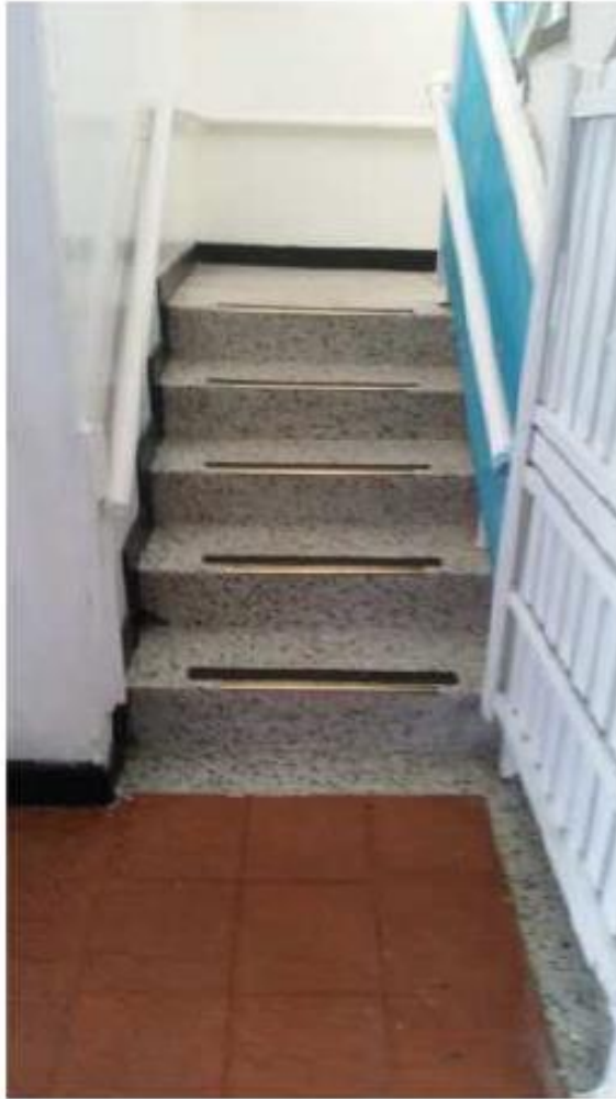
Escaleras del segundo nivel de acceso al tercero
