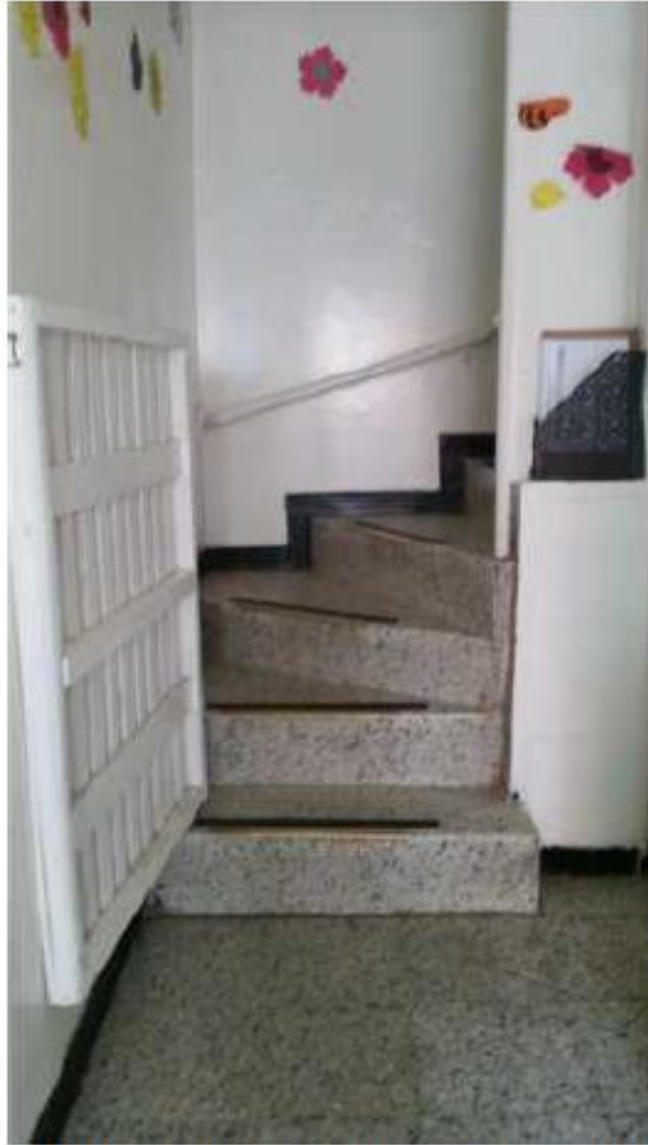
Escaleras del primer nivel de acceso al segundo
