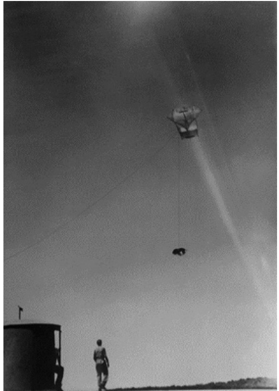
Foto 3. Sondeo aerológico con cometa. (Circa, 1960).
