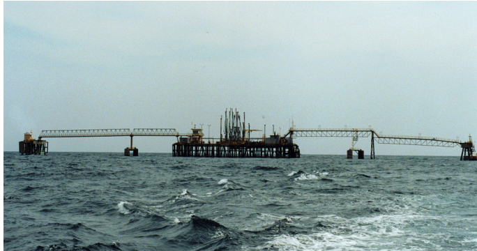
Fig. 3. Observatorio marino de la Universitat Jaume I, en el extremo izquierdo de la plataforma de BPOil, sobre isóbata de -20 metros, (39°56'42"N y 00°01'36"E).
