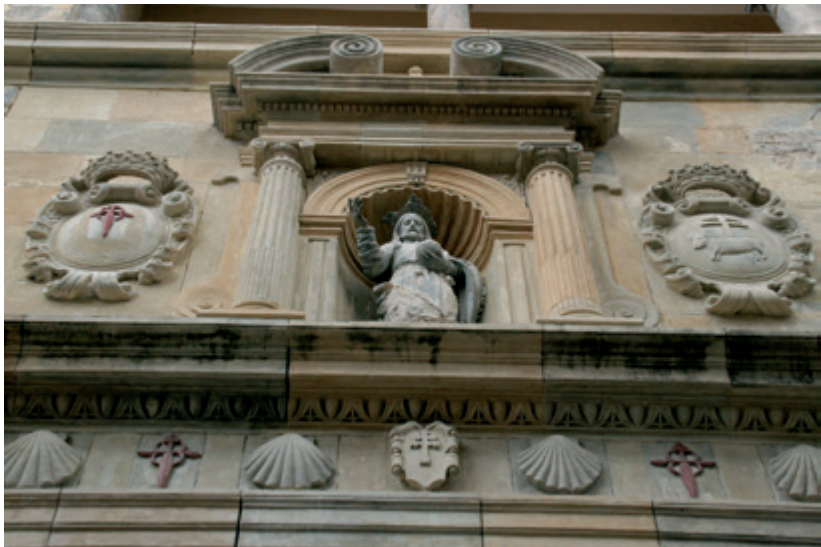
Detalle de la fachada de la Iglesia de El Salvador
