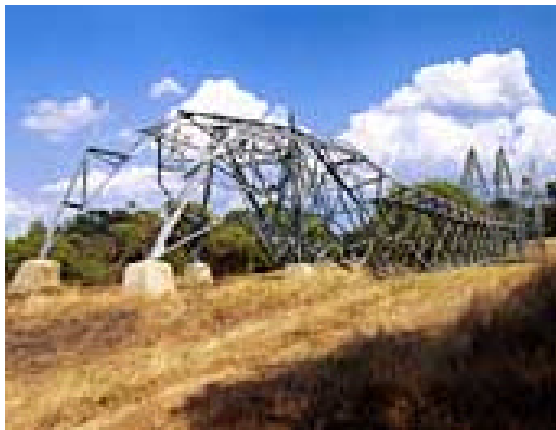
Fig. 2.- Torre de alta tensión doblada por el viento en Malla (provincia de Barcelona).
