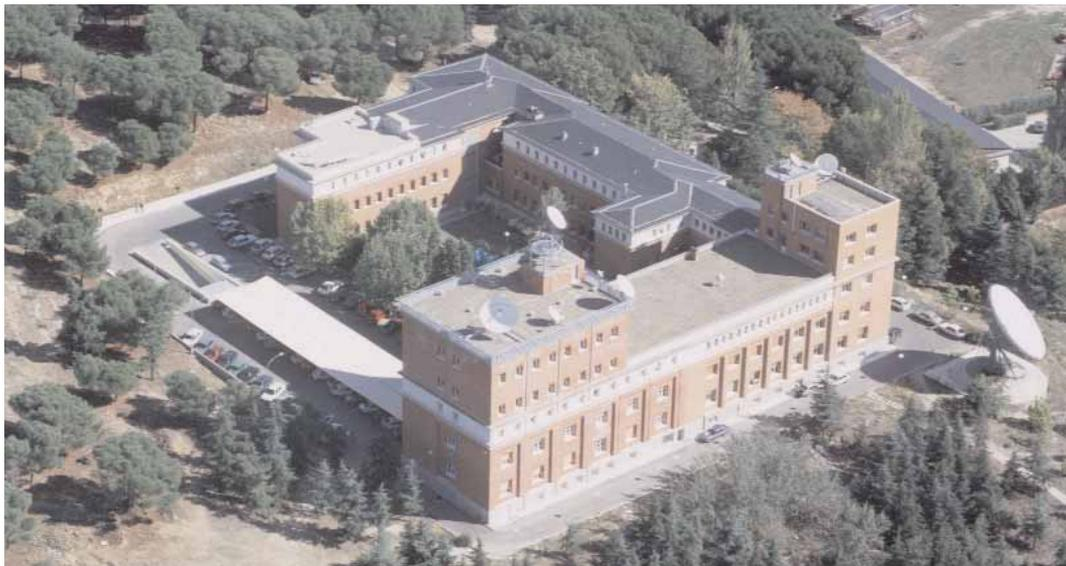
Figura 8. Vista aérea actual del edificio de la Ciudad Universitaria. El ala con las dos torres corresponde a las dos ampliaciones posteriores a la construcción. Además se retiró parte del tejado de pizarra en el ala norte para disponer de otra terraza para instrumentación. La gran antena exterior data de los años ochenta.
