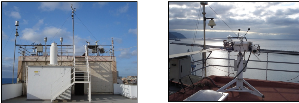
Figura 1.3.- Instalaciones de la estación de Santa Cruz de Tenerife del Centro de Investigación Atmosférica de Izaña (AEMET).
