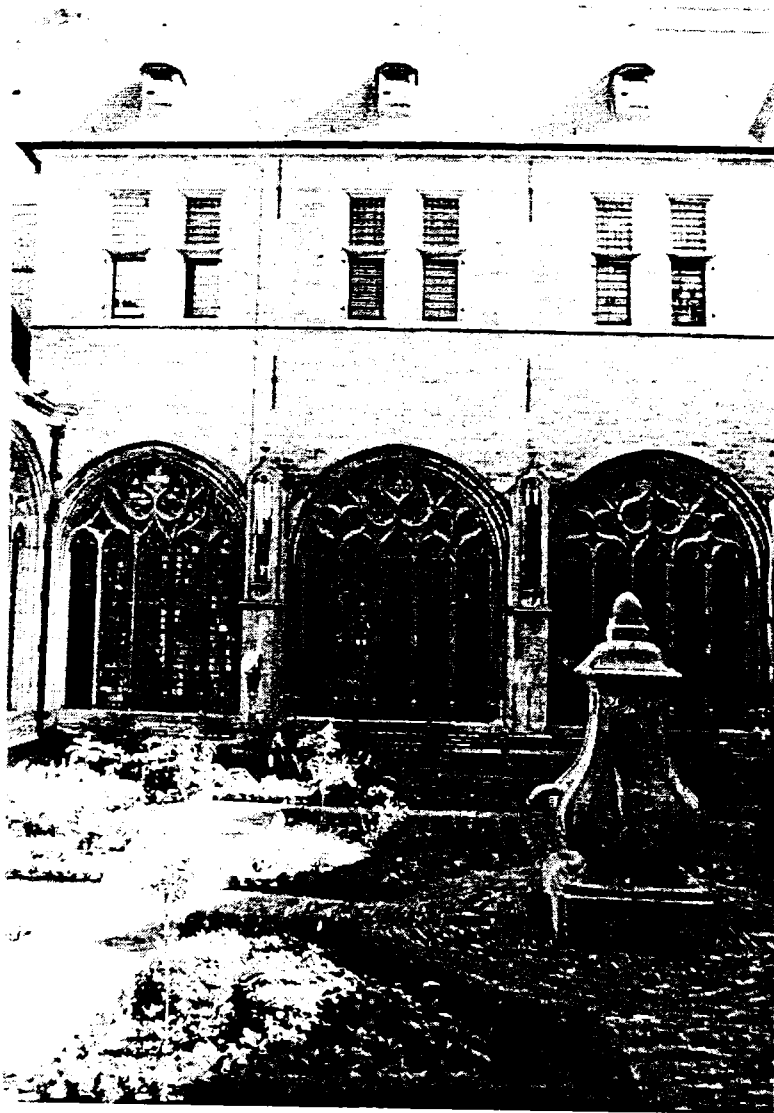
Afb. 8: Westelijke vleugel van het pand met piramidale kappen en hoger opgetrokken muurwerk
