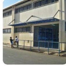
entrada da escola, em Achada Grande
