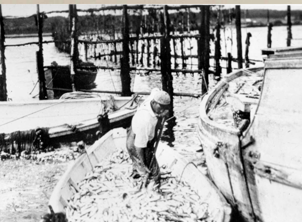
Emptying weir Pêche à la fascine
