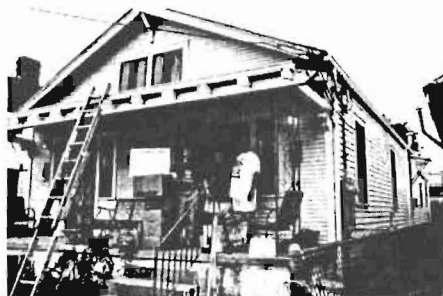
Delgado School: 425 S. Bernadotte
