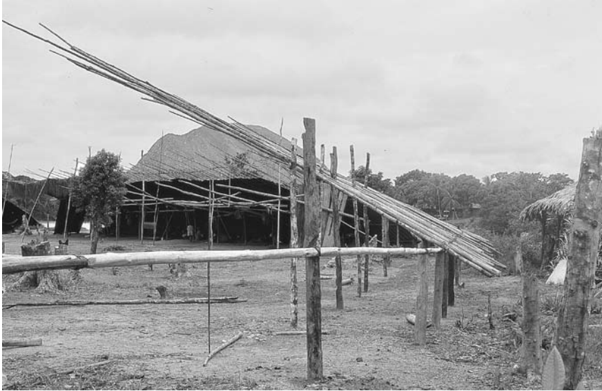
Figura 19. La elemental estructura que sostiene el cobijo del shapono
