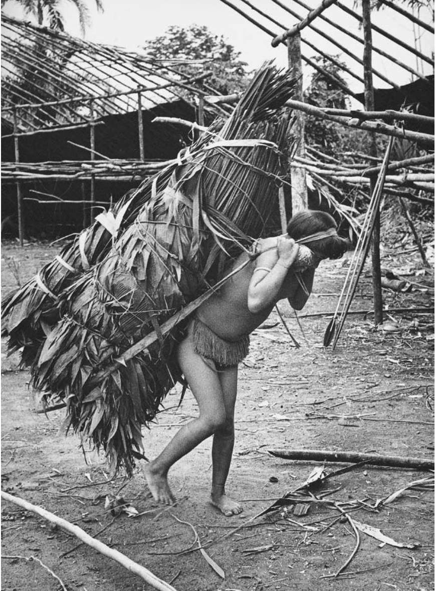
Figura 23. Las mujeres son las que cargan con las hojas de palma y las llevan hasta los pies de la obra, no obstante, todo el mundo, sin límites de edad y sexo, trabaja en la colocación doblando cada hoja sobre los bejucos que enlazan las varas
