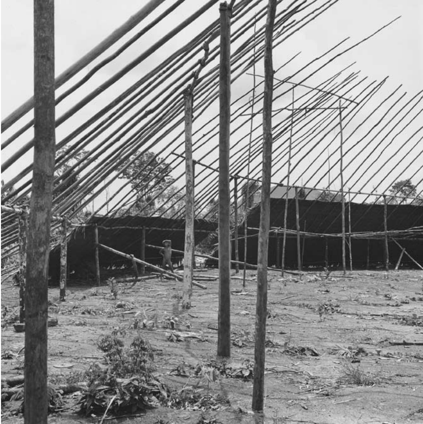
Figura 22. Más detalles constructivos del gran techo de una sola agua que los Yanomami levantan alrededor del gran patio
