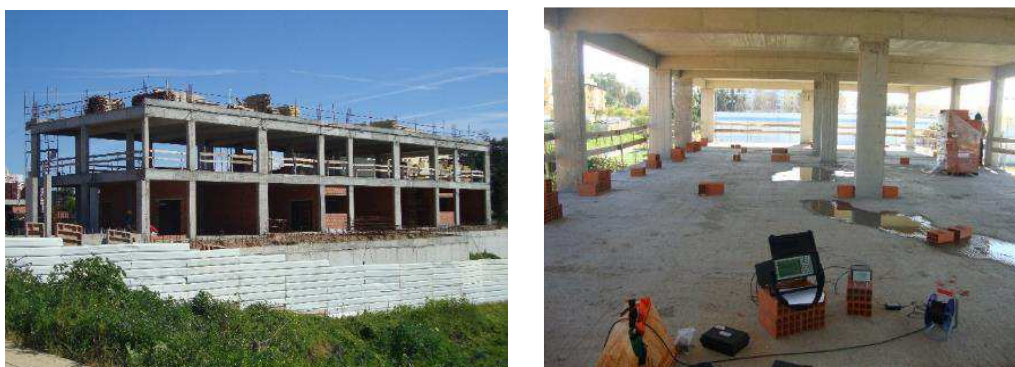
Figura 2 – Vista exterior e interior do edifício da escola.
