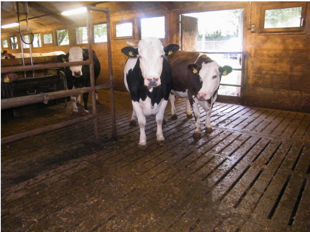
Abb. 3.8.: Betonspaltenboden Laufstall LVG
