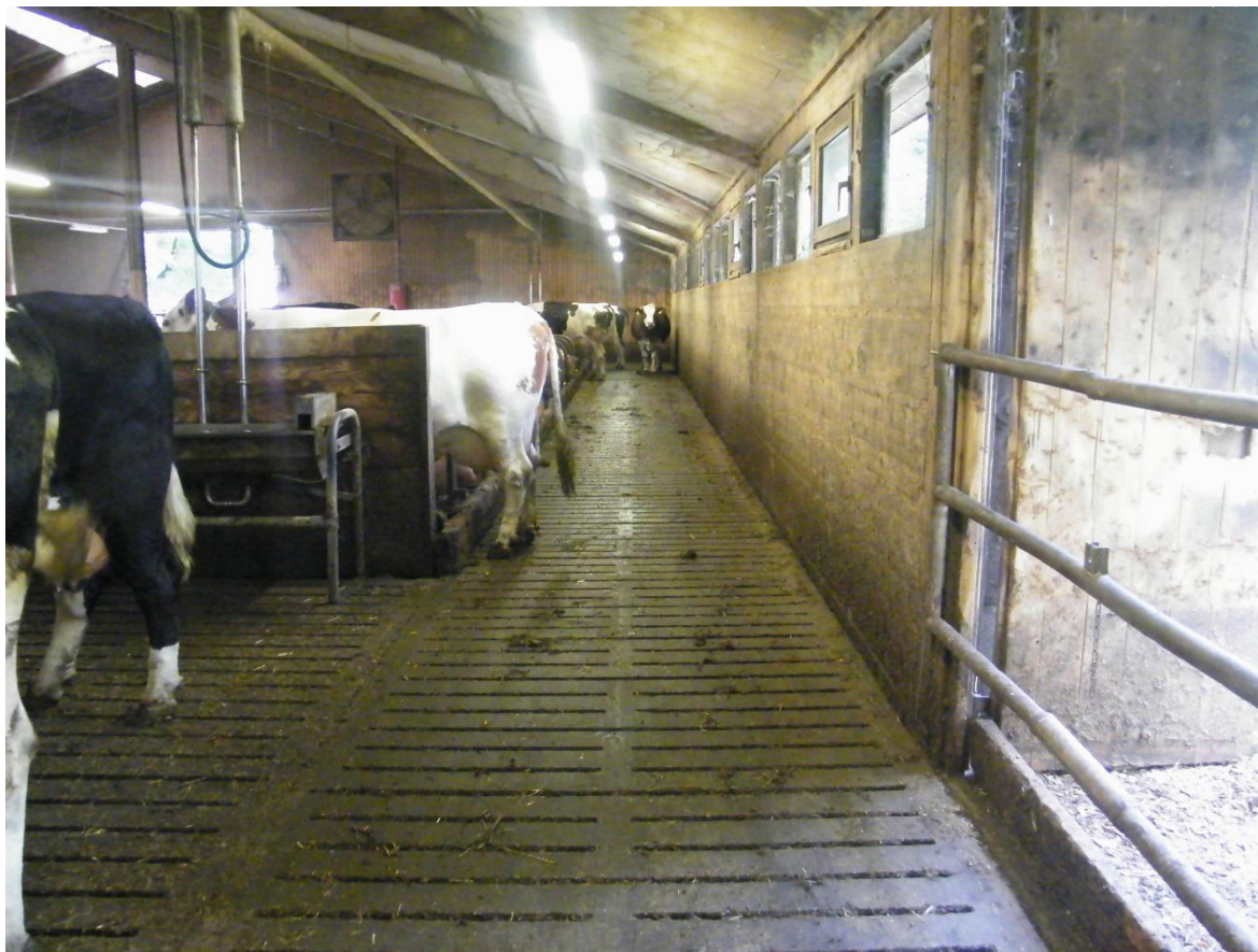
Abb. 3.9.: Betonspaltenboden Laufstall LVG, Laufgang
