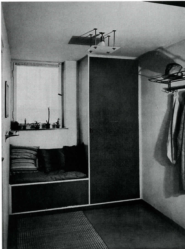
Figure 13 Hermkes, Baublock Adickesallee. Vestibule. Mueller-Wulckow (from Deutsche Baukunst der Gegenwart )
