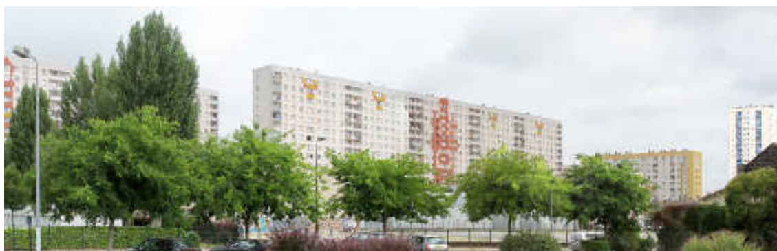
Figura 21: Antes - Intervenção parasita na Cité du Grand Parc, Bordeaux (Fonte: http://www.lacatonvassal.com/data/documents/20140218-193848LV_BookFchA4_HabitatTransfo_bd.pdf , consultado em: jul/2018).
