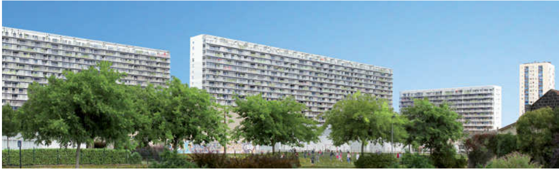
Figura 22: Depois - Intervenção parasita na Cité du Grand Parc, Bordeaux (Fonte: http://www.lacatonvassal.com/data/documents/20140218-193848LV_BookFchA4_HabitatTransfo_bd.pdf , consultado em: jul/2018).
