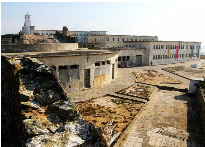
IMAGENS DO ESTADO ATUAL DOS EDIFÍCIOS PRISIONAIS
