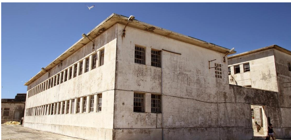
Figura 50 | Vista atual do exterior do bloco A.
