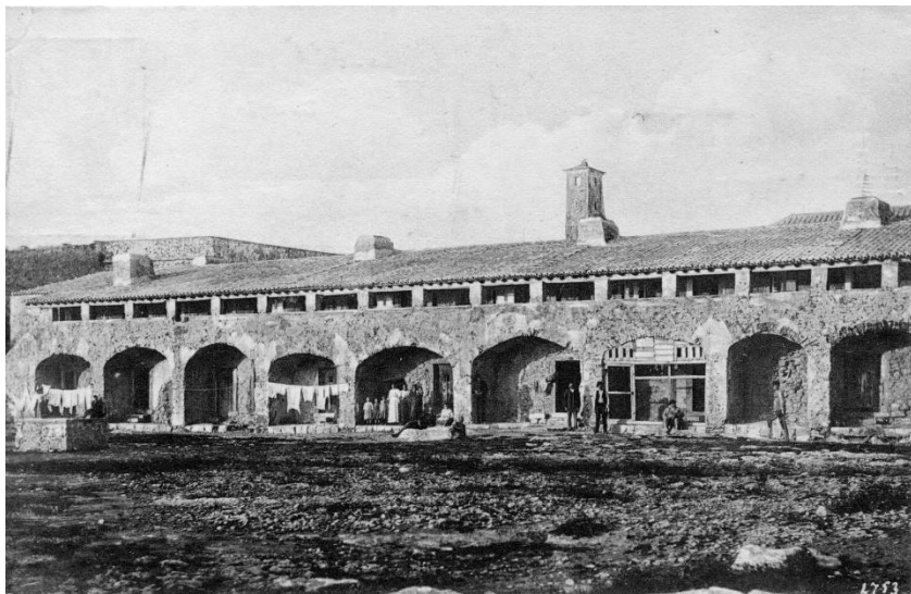
IMAGENS DOS EDIFÍCIOS MILITARES DA FORTALEZA, INÍCIO DO SÉCULO XX
