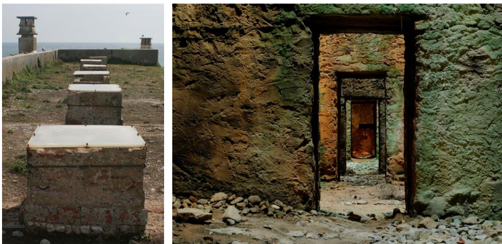
Figura 42|Vista exterior das claraboias que iluminam as casamatas.
