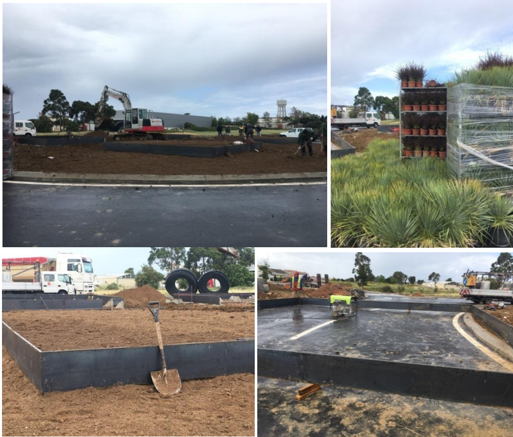
Figura 19 - Trabalhos executados no decorrer da obra (Fonte: autor)
