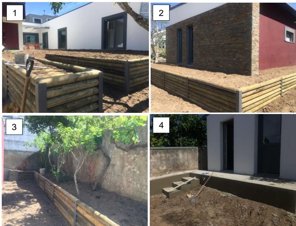
Figura 14 – Trabalhos executados no decorrer da obra em Albarraque: 1 – Frente do edifício principal com acesso pedonal em rampa; 2 – Frente do edifício principal com canteiro em volta; 3 – Zona traseira do edifício principal com canteiro junto ao muro vizinho; 4 – Zona traseira do edifício com rampa de acesso ao edifício anexo (Fonte: autor).
