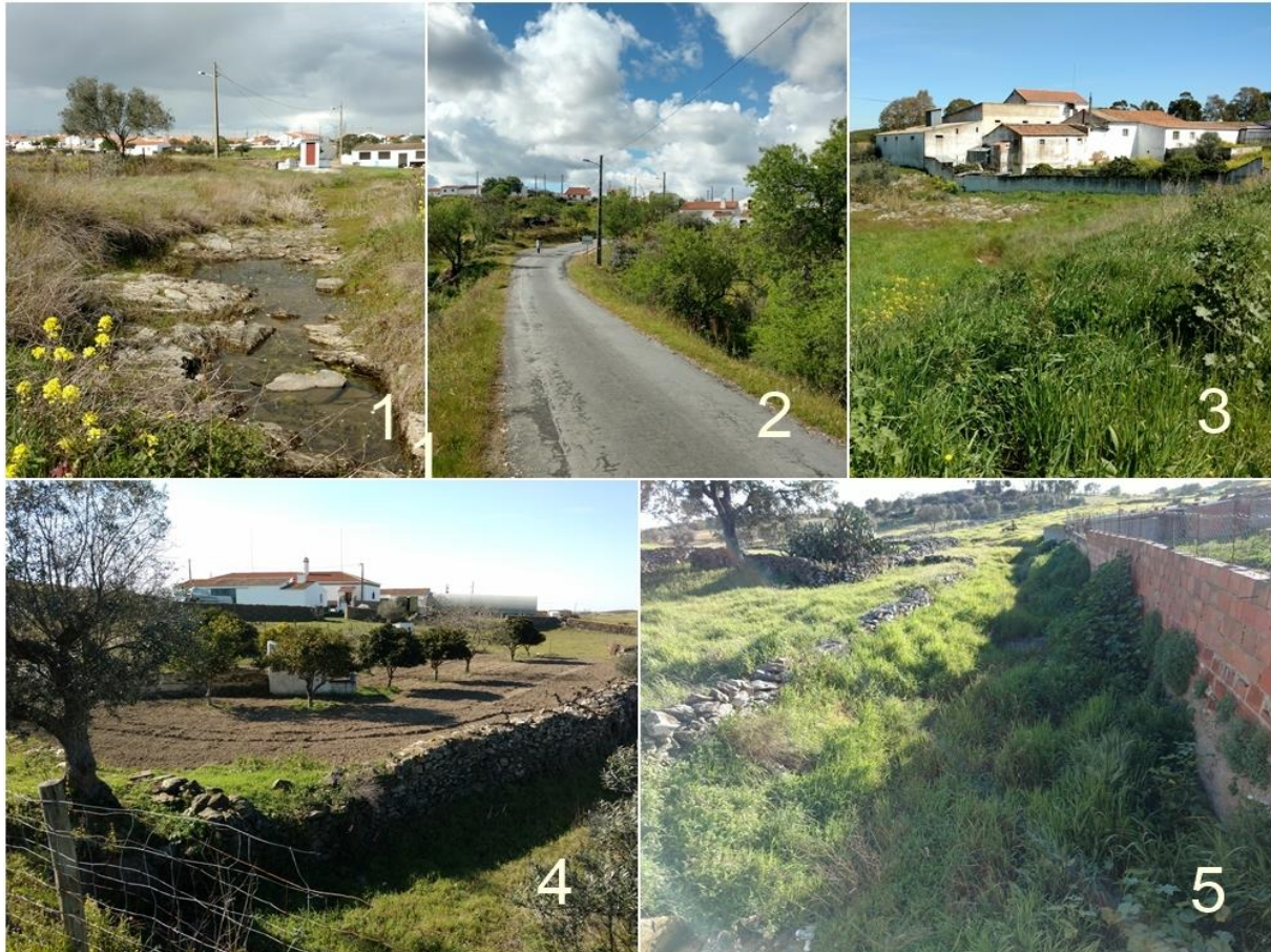
Figura 5 – Fotografias ilustrativas das passagens hidráulicas excluídas pela proximidade de povoações ( Fotografia 1 – Obra 677; Fotografia 2 – Obra 401; Fotografia 3 – Obra 1102; Fotografia 4 – Obra 1335 e Fotografia 5 – Obra 1379)
