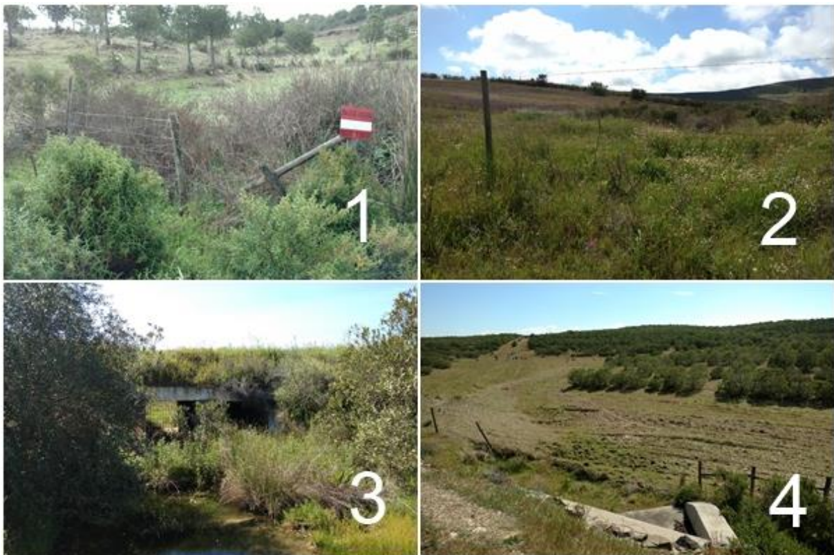
Figura 7 – Vedações nas passagens (Fotografia 1 – Obra 605; Fotografia 2 – Obra 632; Fotografia 3 – Obra 1118 e Fotografia 4 – Obra 1281)
