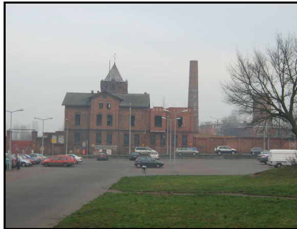
Fot. 2. Budynek administracyjny z wieżą ciśnień i kominem (widok od zachodu, marzec 2009 r.)
