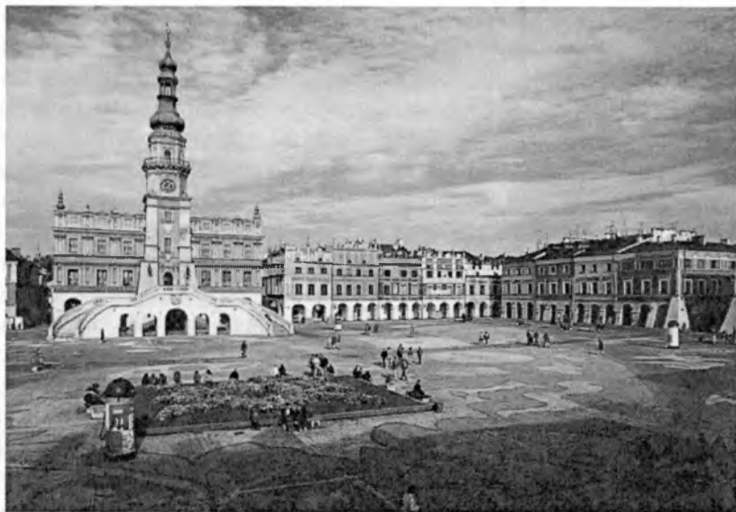
Ryc. 4. Rynek w Zamościu, „graffiti” na nawierzchni placu, 2000
