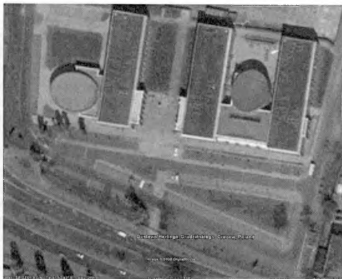
Fot. 4. Kraków – okolice KSW
