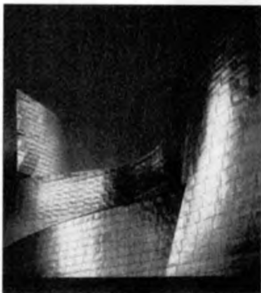
Fotografia 4. Przykład „architektury metalowej”. Budynek z metalową obudową elewacyjną o strukturze połatdowanej
