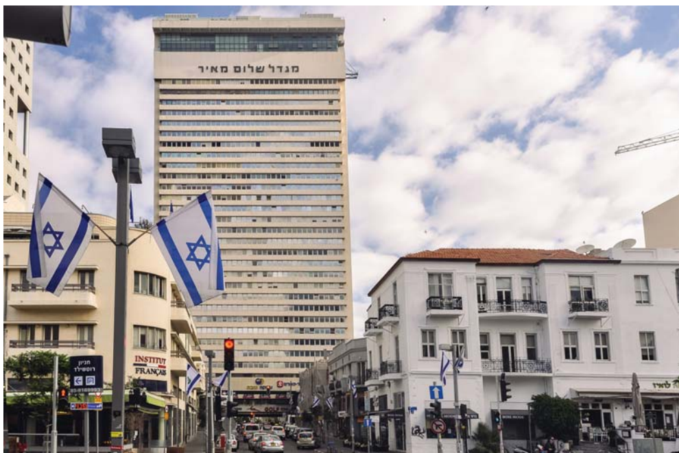
Fot. 14. Tel Awiw. Shalom Meir Tower, liczący ok. 140 metrów wysokości pierwszy wieżowiec w Izraelu, po wybudowaniu najwyższy budynek na Bliskim Wschodzie, postawiony w miejscu, gdzie pierwotnie znajdowało się Gimnazjum Herzliya, widok od bulwaru Rotszylda (Icchak Pearlstein, Gideon Ziv, Meir Levy, 1959–1965), fot. autor.
