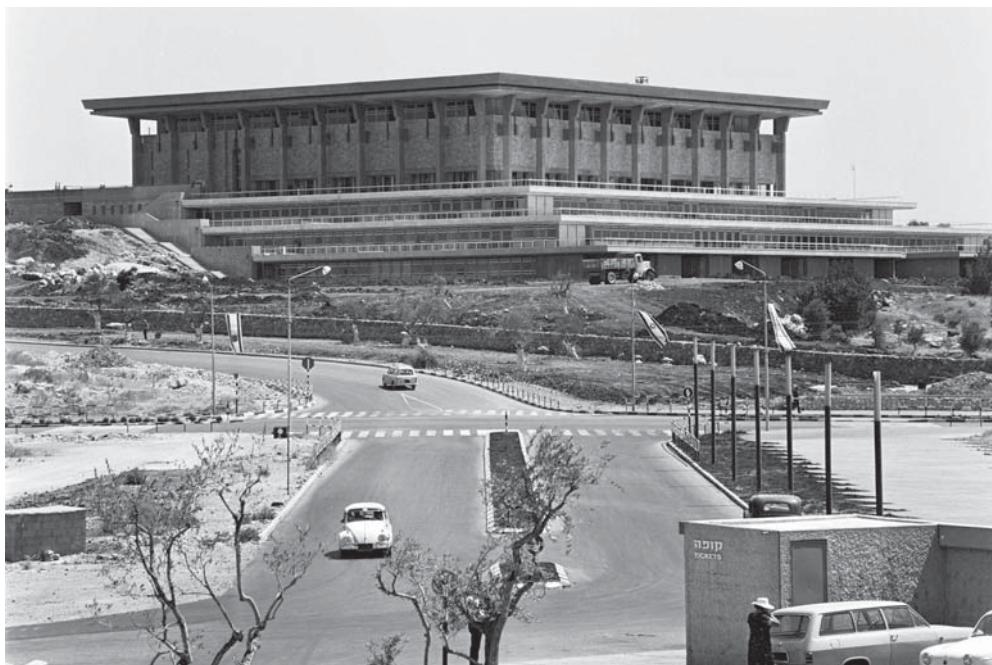
Il. 66. Budowa siedziby parlamentu izraelskiego – Knesetu w Jerozolimie (proj. Dov Karmi, Joseph Klarwein 1957–1966), fot. Cohen Fritz, 1965. Źródło: Government Press Office, The State of Israel, National Photo Collection, no. 5409.
