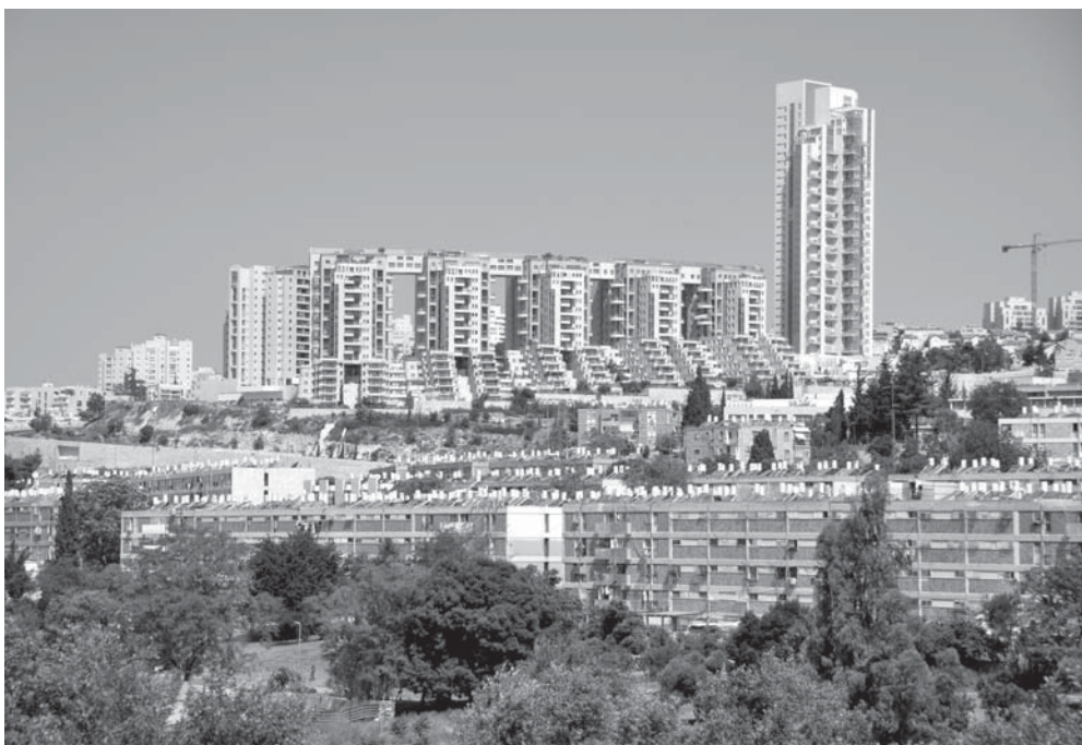
Il. 94. Osiedle Holy Land na południowych przedmieściach Jerozolimy, z najwyższym budynkiem wysokości 121 m, dominującym sylwetę miasta (Ram Karmi, Tishbi-Rozin, Moshe Tzur 2009), 2014, fot. autor.
