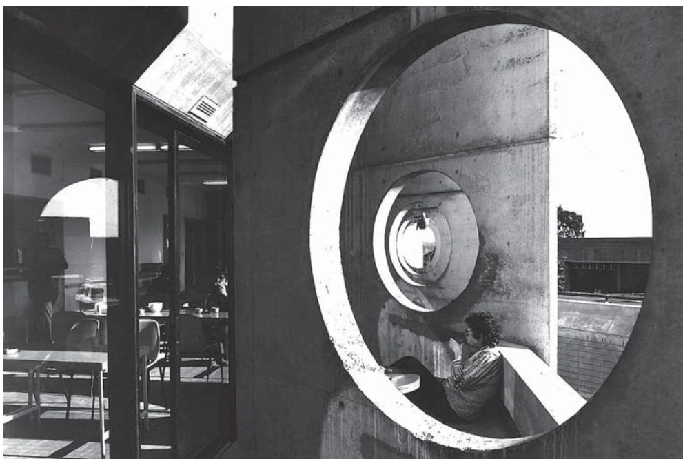
Il. 52. Szkoła medyczna uniwersytetu w Tel Awiwie, betonowy detal elewacji (Arieh Sharon i Eldar Sharon, 1970). Źródło: Arieh Sharon Archive, ariehsharon.org/Archive .
