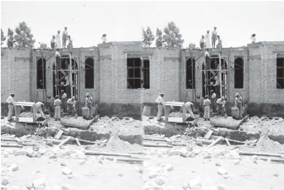
Il. 20. Tel Awiw, budowa domu z cegły silikatowej, zdjęcie stetoskopowe, ok. 1920–1930. Źródło: Matson Collection, US Library of Congress, no. LC-M32-B-451.
