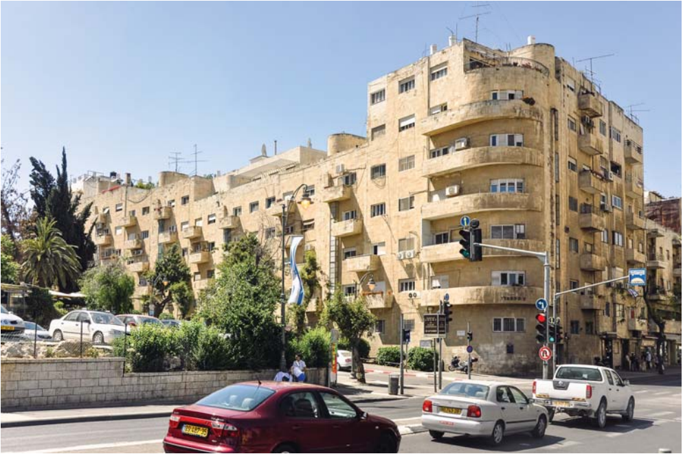
Fot. 51. Beit HaMa'alot, jeden z pierwszych modernistycznych budynków w Jerozolimie (Alexander Friedman i Meir Rubin, 1935), fot. autor.
