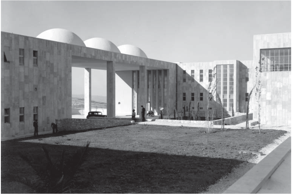
Il. 24. Brama wejściowa i dziedziniec szpitala Hadassah, fot. 1934–1939, fot: American Colony Photo Dept., Źródło: Matson Collection, US Library of Congress, no. LC-M32-10748.
