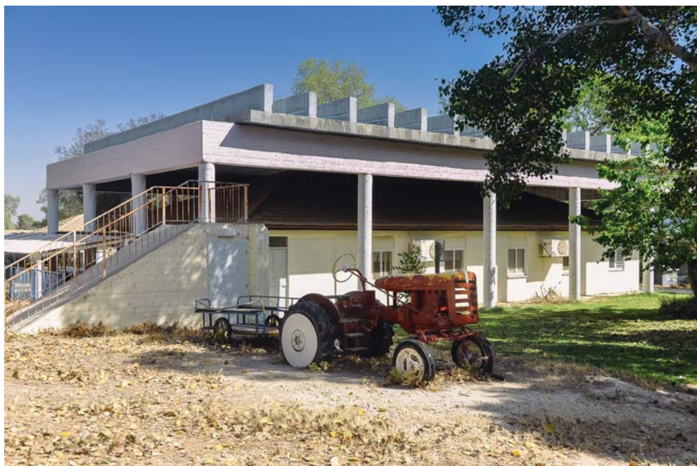
Fot. 8. Budynek szkoły w kibucu Yad Mordechai osłonięty żelbetową pokrywą, która go chroni przed raketami wystrzeliwanymi z sąsiedniej Strefy Gazy, na pierwszym planie stary traktor – używany teraz jako zabawka, fot. autor.
