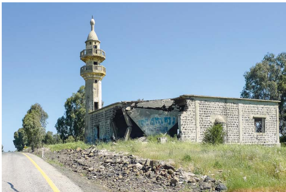
Fot. 31. Ruiny zniszczonego meczetu na Wzgórzach Golan, fot. autor.
