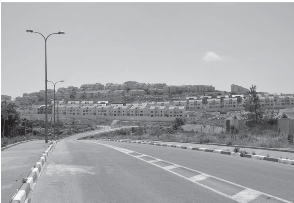
Il. 86. Budowa enklawy Moria na osiedlu Ariel, 2014, fot. autor.
