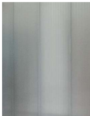
10. Fundacja Prada. Rem Koolhaas. Mediolan 2015. Detal poliwęglanowej okładziny strefy wejściowej budynku głównego.
