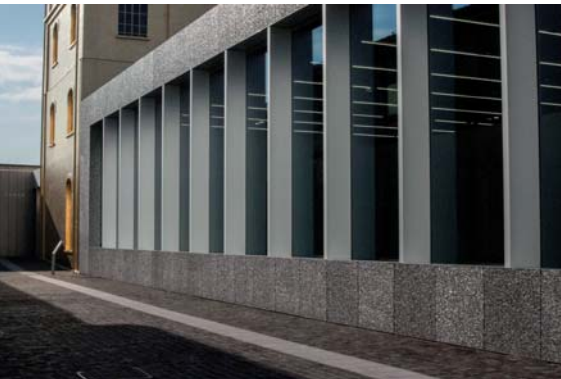
3. Fundacja Prada. Rem Koolhaas. Mediolan 2015. Podium. Panele ze spienionego aluminium w kontraście ze „złotą elewacją”.
