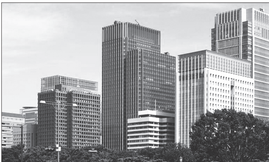
Fot. 2. CBD Tokio–Chiyoda. Fragment zabudowy komercyjnej Marunouchi widziany od strony Pałacu Cesarskiego, tworzącej jedno z globalnych centrów finansowych świata.
