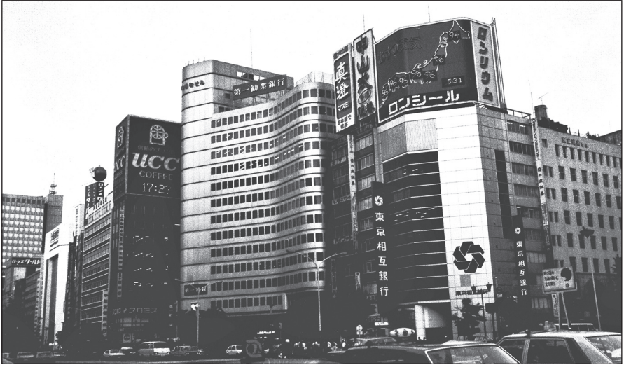
Fot. 20. CBD Tokio–Chuo. Fragment zabudowy biurowo-handlowej w zespole Yaesu, sąsiadującym od wschodu z centralnym dworcem kolejowym miasta Tokio. Zwieńczająca jeden z budynków elektroniczna mapa pogody Japonii zastąpiona została aktualnie telebimem prezentującym notowania giełdowe oraz kursy walut.
