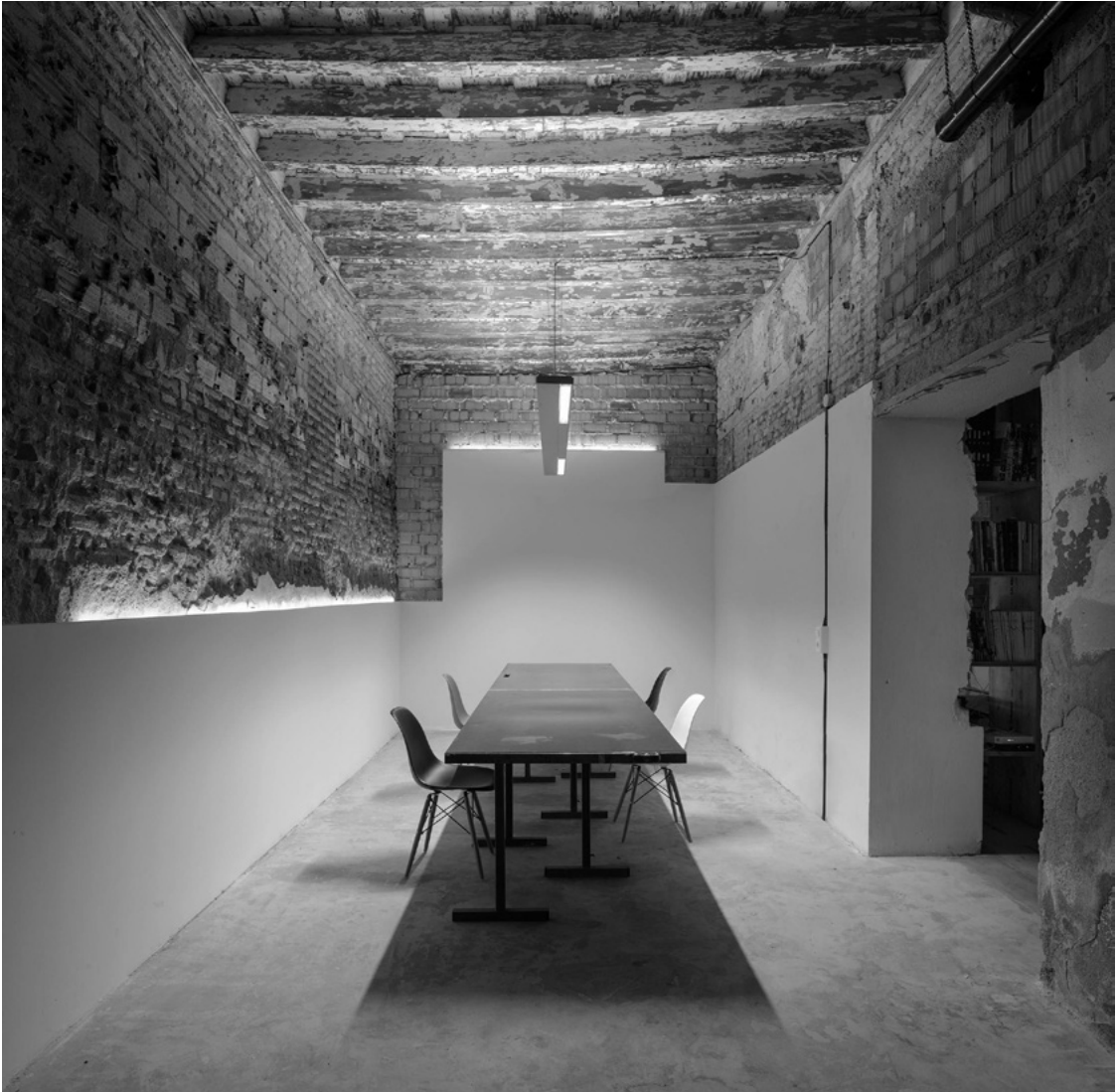
Fragmentos de cartón-yeso encontrado transformado y conectado como infraestructura de electricidad e iluminación indirecta. En el centro: puerta-mesa desplazada en el espacio de reunión y proyecciones. Fotografía: Fernando Alda, 2015.
