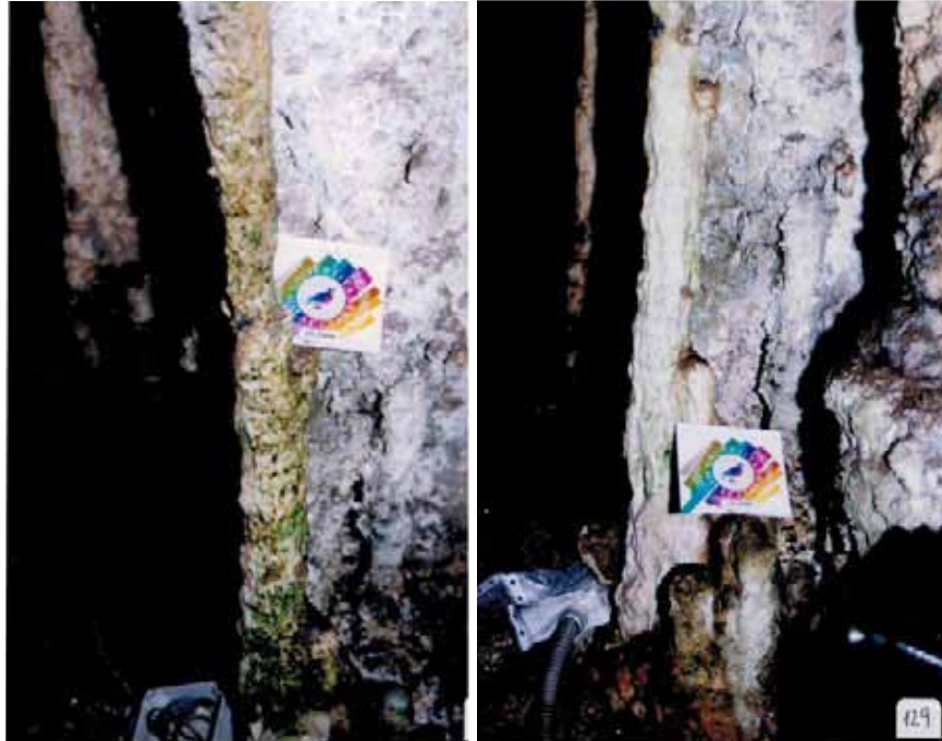
Figura 4.3. Una de las superficies limpiada mediante cepillado y agua a presión. A la izquierda, aspecto antes de la limpieza y, a la derecha, aspecto después de la misma (Marín y Marín-Olalla, 2000).
