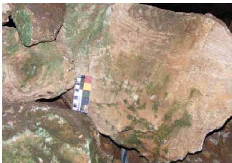
Figura 4.6. Imagen de la zona Ne.1 (noviembre de 2011).
