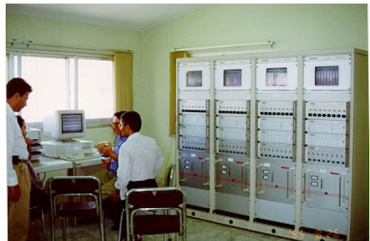
Ilustración 8-7. Controles de una estación de ensayos
