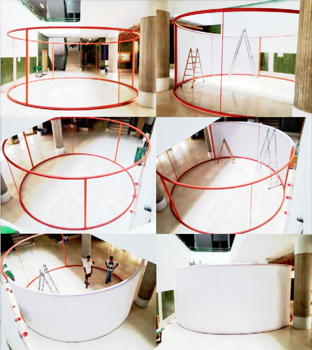
Premontaje de la instalación del AtechRoom .
