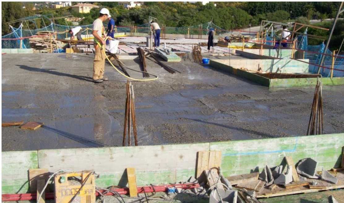
Figura 4-4: Curado mediante riego directo durante el fraguado y primer período de endurecimiento del hormigón.
