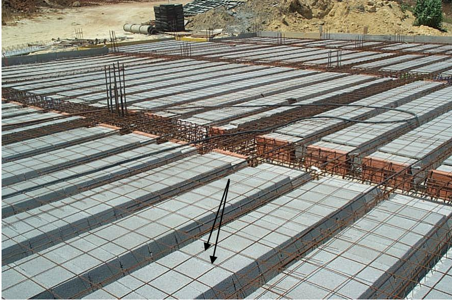
Figura 4-5: Armadura de reparto en la capa de compresión de forjados
